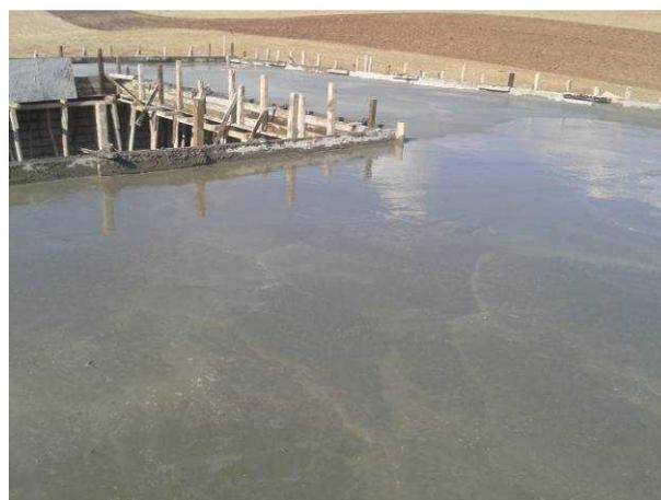
天井スラブへコンクリート流し込み作業が完了し、
