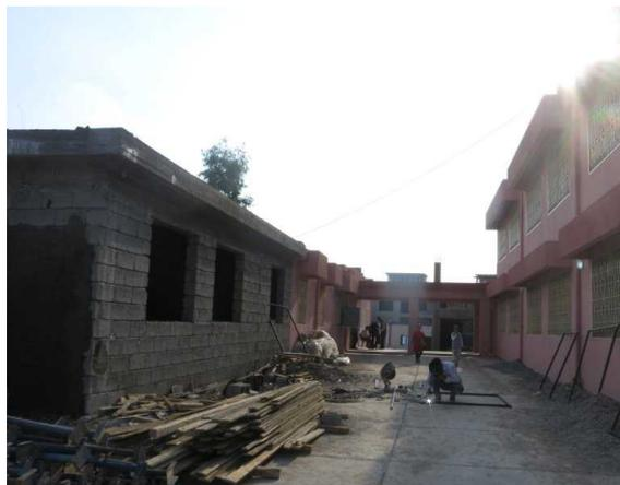
職員室(倉庫含む)の外壁(写真左)にコンクリート塗装作業ならびに窓枠設置作業の開始
