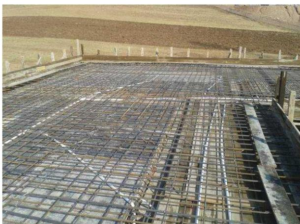
天井スラブ打設のための鉄筋設置完了
