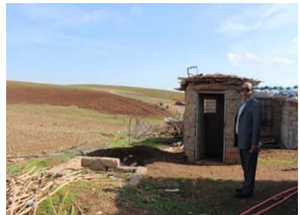
小学校唯一のトイレ（写真右）（写真左側にもう 1つのトイレがあったが倒壊してしまった）
