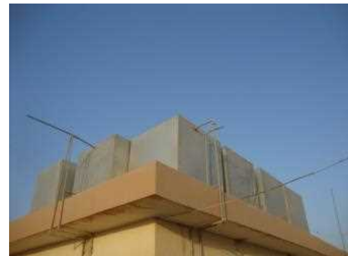
3. Al Hawra 小学校の給水タンク (事業前)
