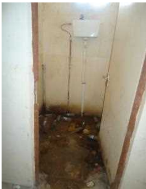
10. Omar Bin Al Khataab 中学校のトイレ（事業前）
