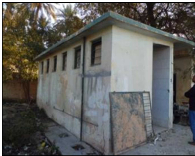
1. トイレの概観（Al Badia 小学校）
