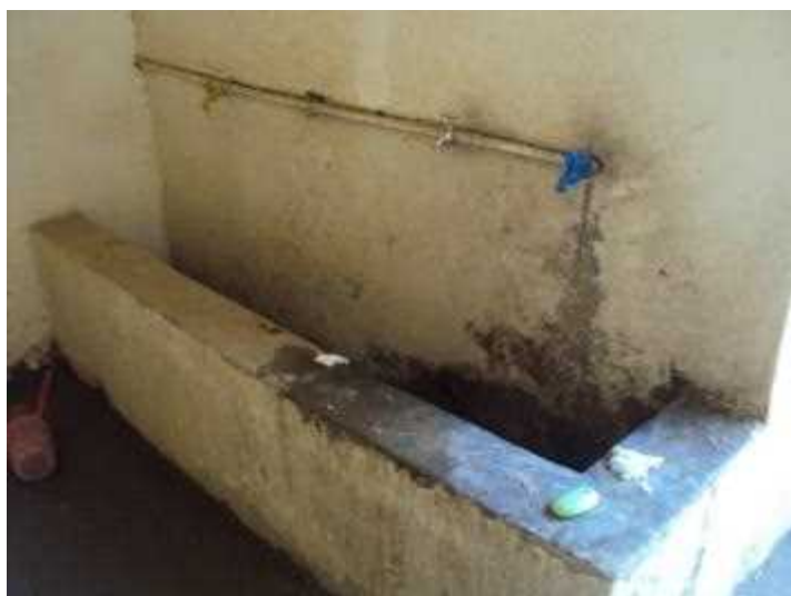
7. Al Izdihar 女子中学校の手洗い場（事業前）
