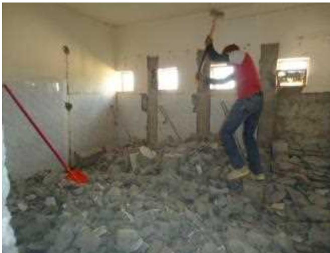
9. 使えない洗面台を砕いている建築作業員 （Al Shurook 女子中学校）
