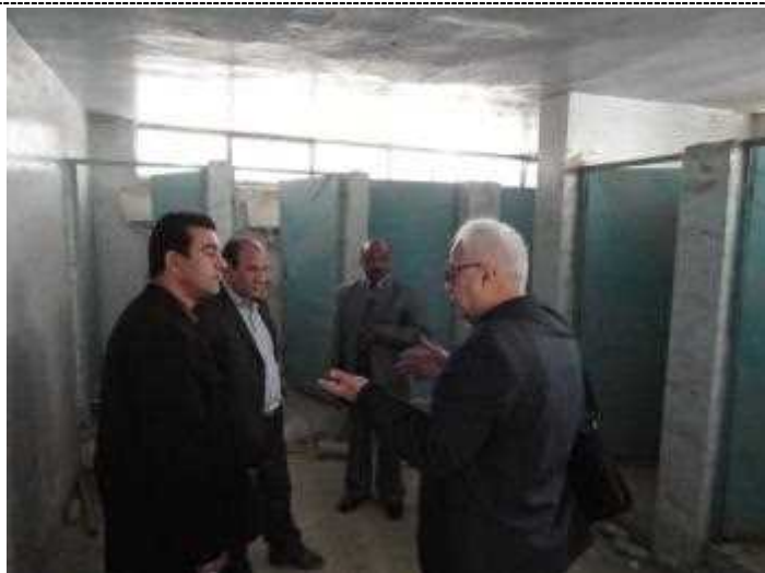
2. 工事途中のトイレの状況を教育省職員に説明する JEN 職員 (Qibaa 中学校)
