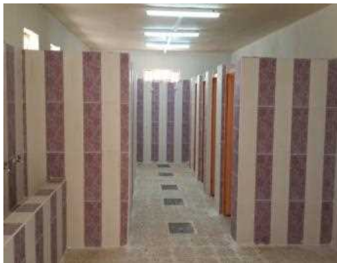
10. Omar Bin Al Khataab 中学校のトイレ施設（事業後）
