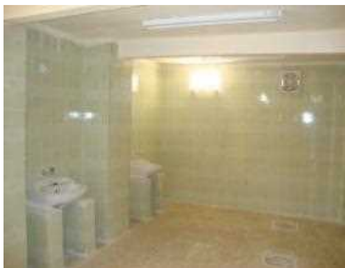
6. Ibn Hayan 女子中学校の修復された洗面台
