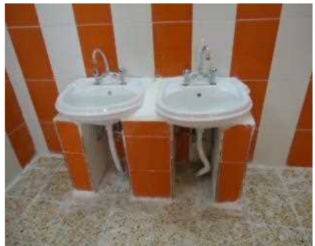
9. 完成した新しい洗面台 （Al Shurook 女子中学校）
