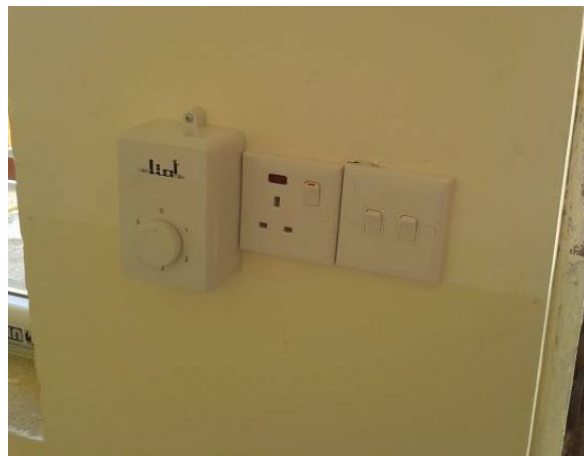
新校舎内の配電設備
