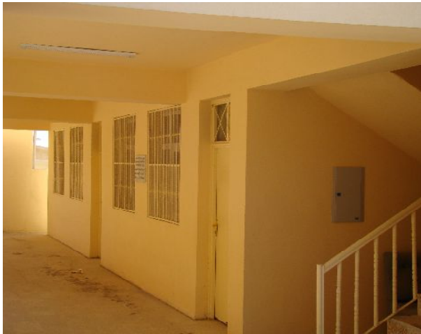
増築した4教室（2階建て2教室）の1階部分
