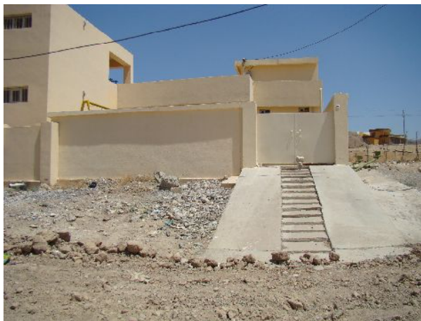
修復した隣接既存校舎の外観
