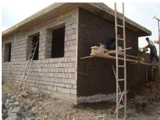
2 教室増築校舎外壁コンクリート塗装開始
