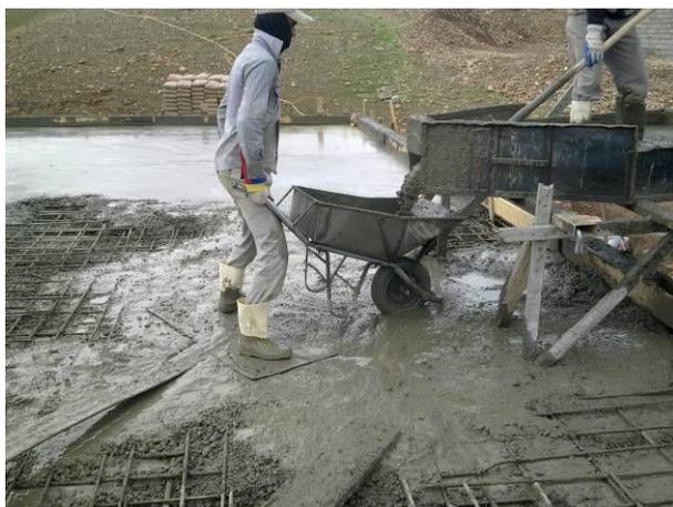
天井部分へコンクリート流し込作業
