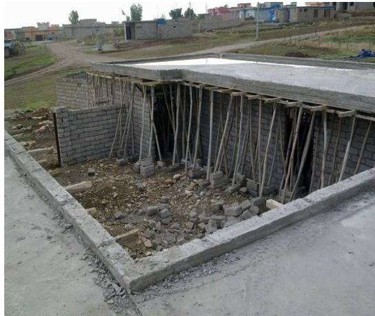
天井のコンクリートを乾燥させて固めている
