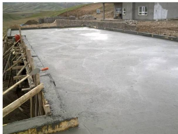
天井部分へコンクリート流し込み作業完了
