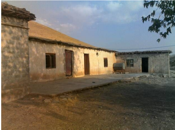
学校の前景：地元の地主が小さな民家を 教室用に寄贈、のちに住民によって1教室と 職員室が増築された
