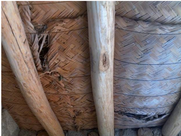
伝統的な屋根は木材と土でできているため穴が空きやすく、雨漏りや動物の糞が教室に落ち、衛生的に問題である
