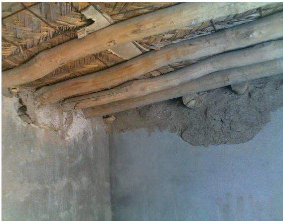
教室の天井には穴が空き、雨や糞が教室に入ってくるため、不衛生である
