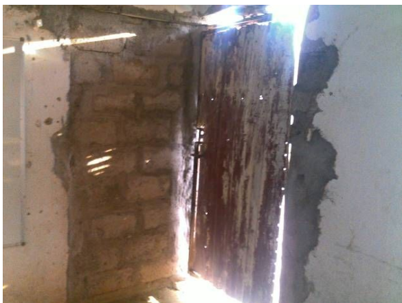
劣化した教室のドア
