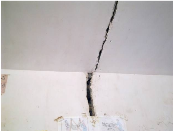
亀裂が入った教室の壁と天井
