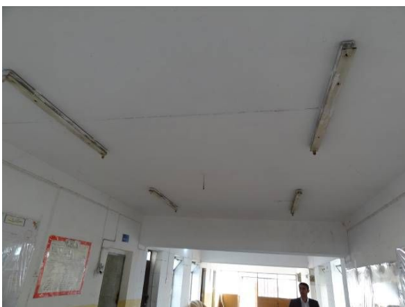
電気配線が故障しており、 電気が使用できない
