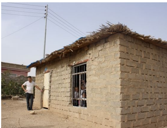
外壁にひびが入っている
