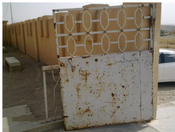
劣化した正門ゲート
