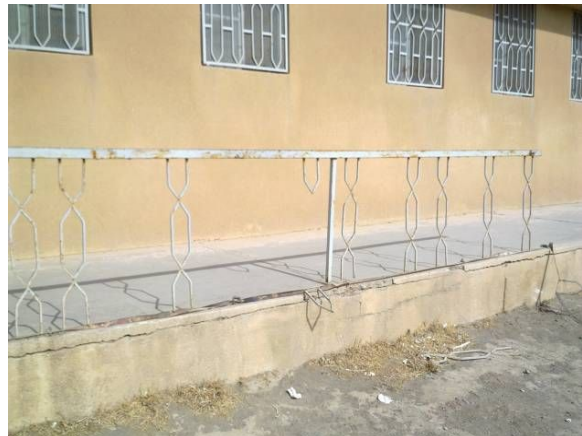
老朽化し一部壊れている鉄製フェンス
