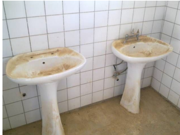
トイレの手洗い場：蛇口が壊れて 使用できなくなっている
