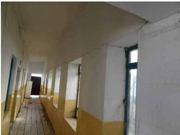
壁に亀裂が入り、床の破損もひどい
