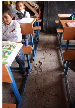
床にひびが入っている
