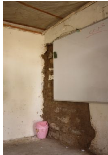
壁の塗装が大幅にはがれ、天井上部にひびが入り、倒壊の恐れあり
