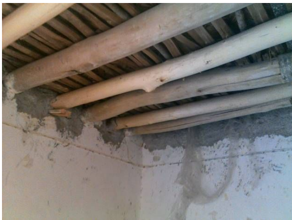
教室の屋根は伝統的な工法で作られた屋根 だが、雨漏りで床がドロドロになり不衛生
