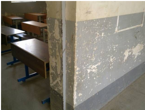
ペンキが剥がれ、壁の所々に 亀裂ができています
