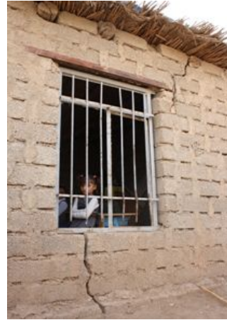
基礎がしっかりつくられなかったため、大きなひび割れができ、倒壊の危険がある
