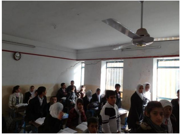
教室の後方の壁に亀裂が入っている
