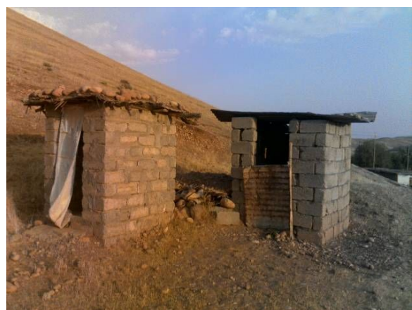
屋外にあるトイレ2基：詰まっている ためほとんど使われていない
