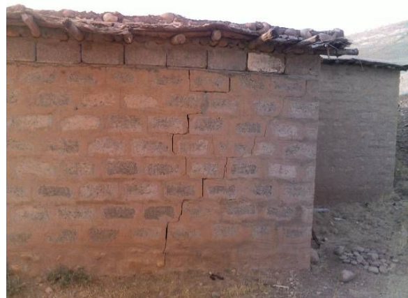
教室の壁には亀裂が入り、 倒壊の危険がある
