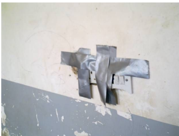
電気スイッチのカバー落下防止 のため、ガムテープで補強
