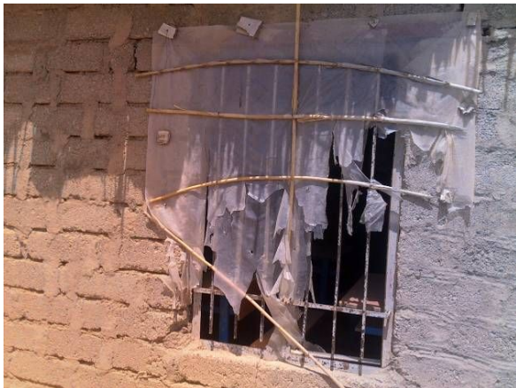
窓にはガラスがなく、冬場はビニールシートで覆って寒さをしのいでいる
