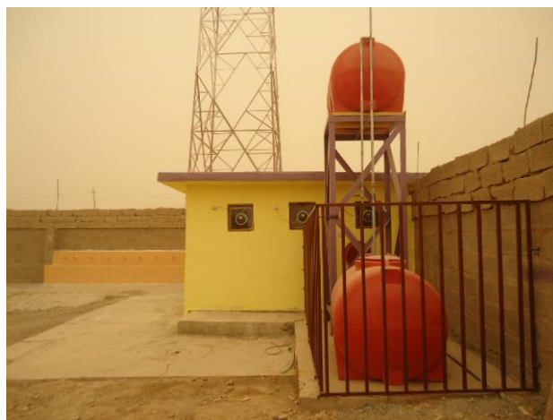
水タンク設置後の裏庭 (Kani primary school)
