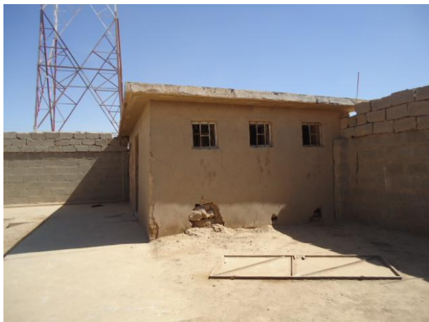
水タンク設置前の裏庭 (Kani primary school)
