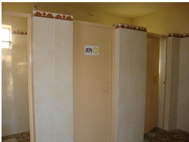
修復後、JEN のロゴを入れたトイレ (アンバール県 Al-Mafakher primary school)
