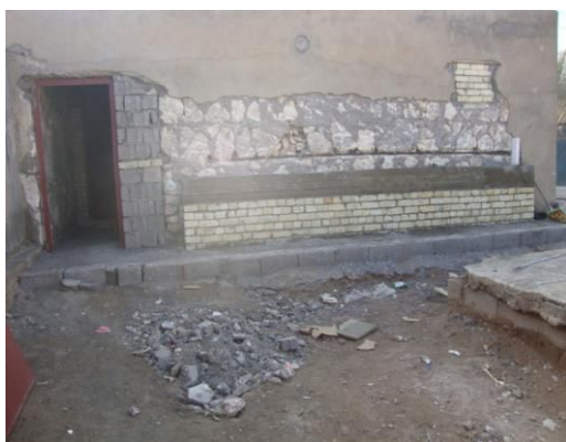
水道設備修復 Al-Khulafa school (2011.12&2012.3)
