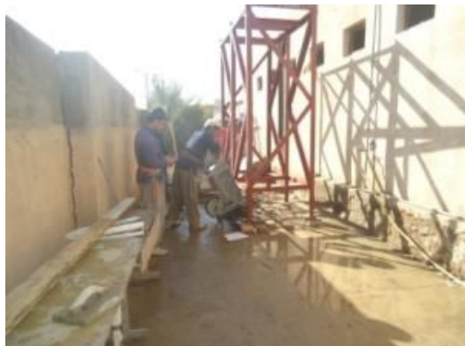
水タンク設置 Al-Keram school (2011.12&2012.3)
