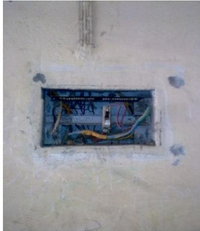
感電の恐れのある剥き出しの電線 (バグダッド県 Shuhadaa Al Islam 中学校)
