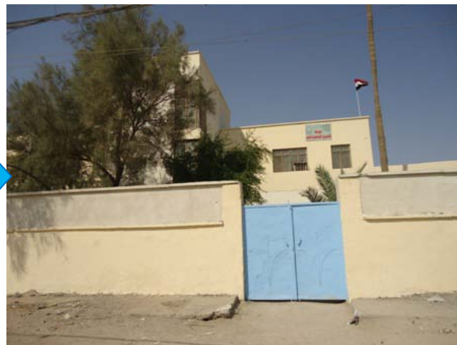
修築後の学校正門。
