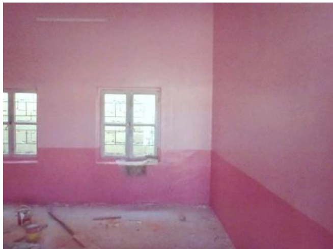
修築後の教室。壁を補修した上で、塗装し直した。（なお、この後、床にはタイルを敷き詰めた。）
