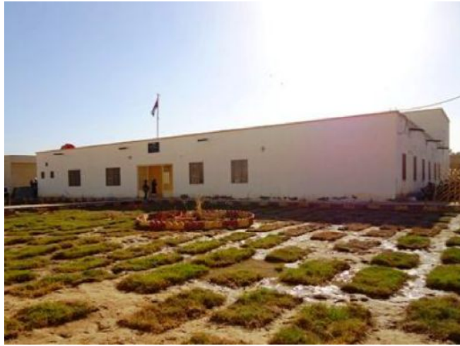
修築後。周辺地域よりも地面が低いため汚水が溜まり易かったが、排水等を修理し、さらに土を盛り、庭園造った。
