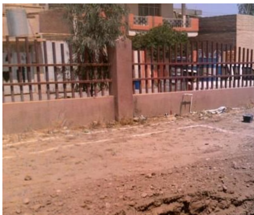
敷地に白線を引いたところ (7月11日撮影)
