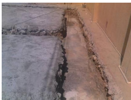
基礎をコンクリートで固める (8月23日撮影)
