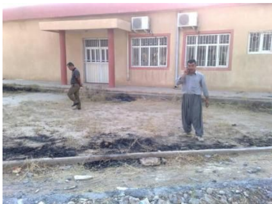
業者へ引き渡された増築工事サイト (7月13日撮影)
