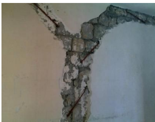
ひびが入った壁の補強作業 (8月11日撮影)
