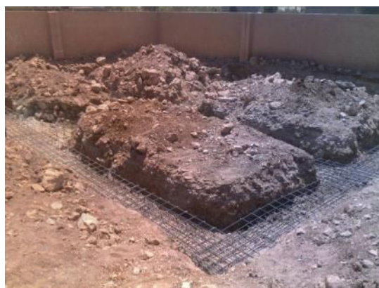
基礎鉄筋敷設作業完了 (8月10日撮影)
