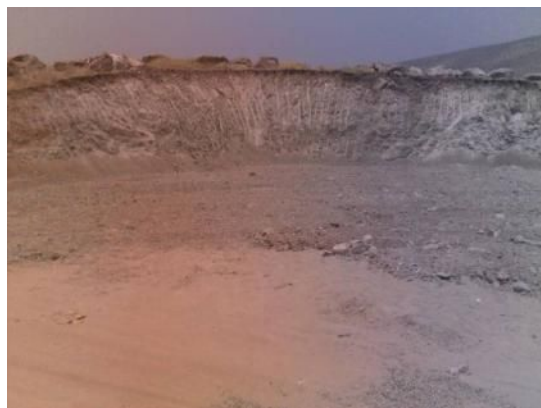
更地整備作業 (7月18日撮影)
