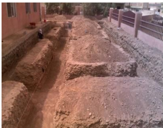
基礎掘削工事完了 (7月16日撮影)
