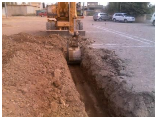
基礎掘削工事作業 (7月31日撮影)
