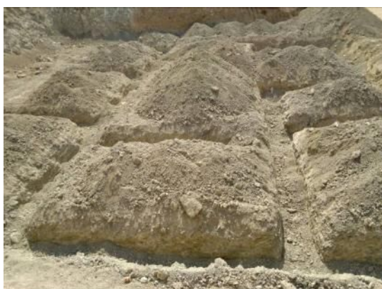
基礎掘削工事完了 (7月27日撮影)
