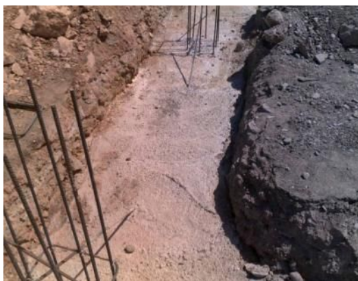
基礎打設工事完了後の乾燥作業 (8月20日撮影)
