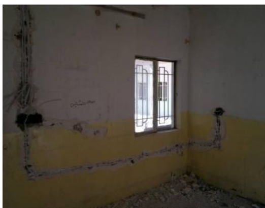
電気配線補修のため、壁掘削作業実施 (7月27日撮影)
