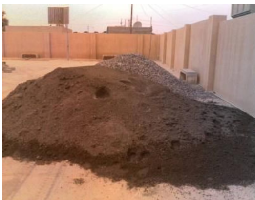
検査に合格した建設資材の砂と砂利 (7月17日撮影)
