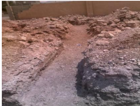
増築サイトの基礎掘削工事完了。 (7月25日撮影)
