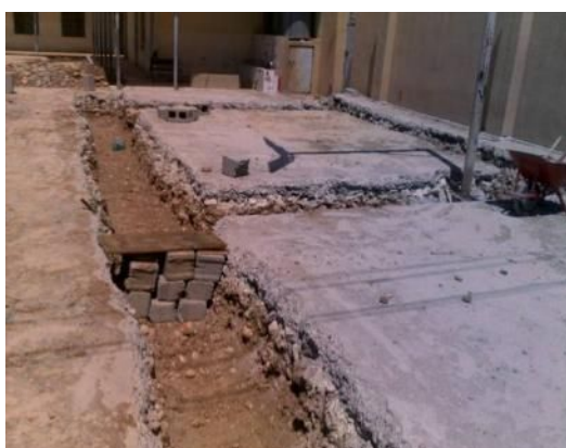
基礎掘削作業 (8月8日撮影)
