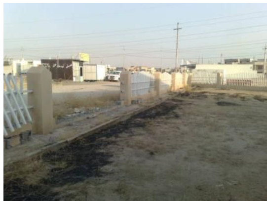
工事のために一時的に取り除かれたフェンス (写真左の中央部分) (7月14日撮影)
