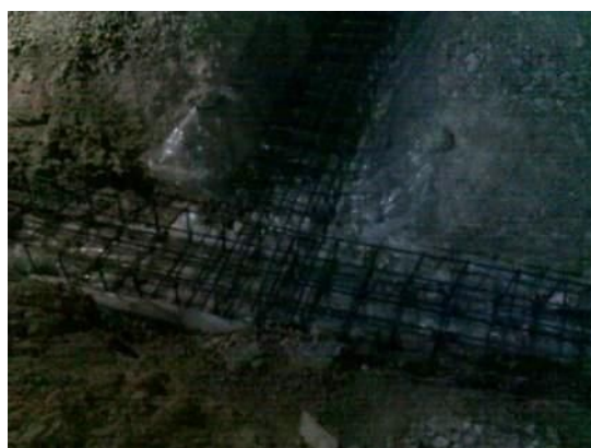
鉄筋組立と設置作業 (8月18日撮影)
