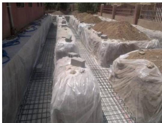
基礎工事の鉄筋組立完了 (7月27日撮影)
