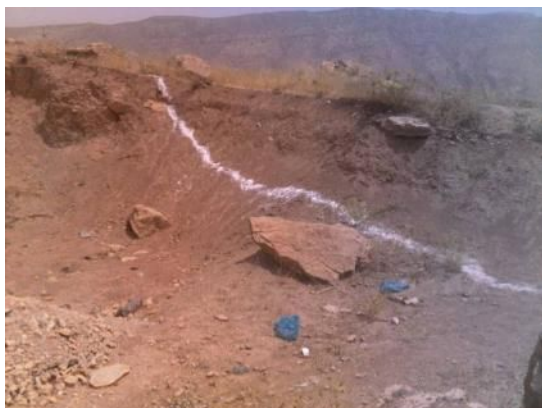
建設サイトとの境目に白線をひく (7月12日撮影)
