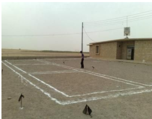
増築する敷地に白線を引いたところ (7月19日撮影)
