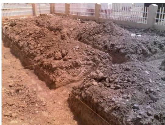
増築する教室の基礎掘削作業完了 (8月4日撮影)
