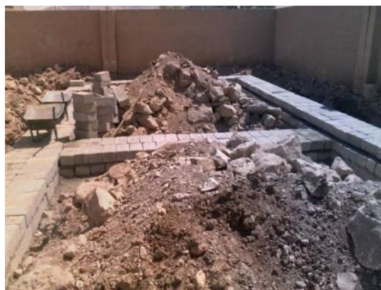
基礎組積作業 (8月25日撮影)
