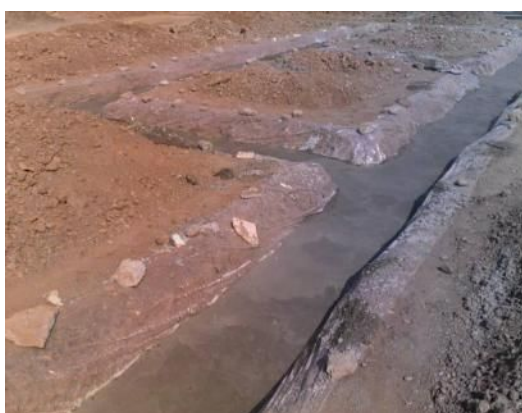
増設部分の基礎をコンクリートで 固める作業完了 (8月21日撮影)
