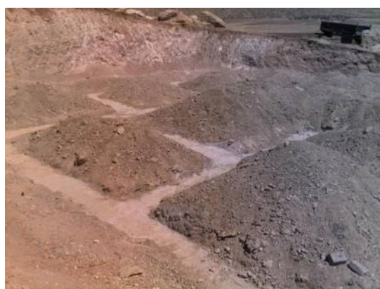
基礎打設工事完了 (8月20日撮影)
