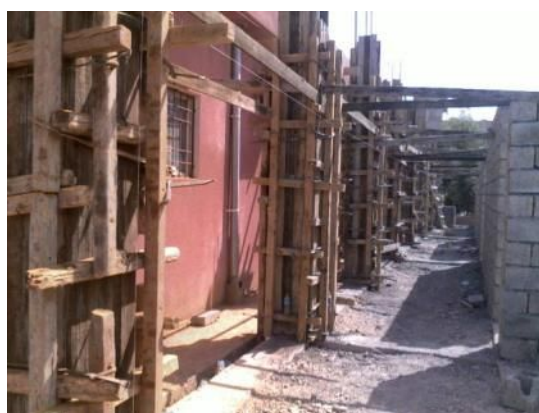
1階通路柱打設作業および1階教室組積工事完了(8月25日撮影)
