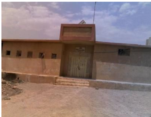
業者に引き渡した増築サイト(写真手前) (7月12日撮影)
