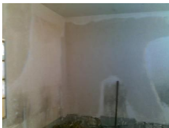
ひびが入った箇所補強後、上からコン クリートを塗装した (8月16日)
