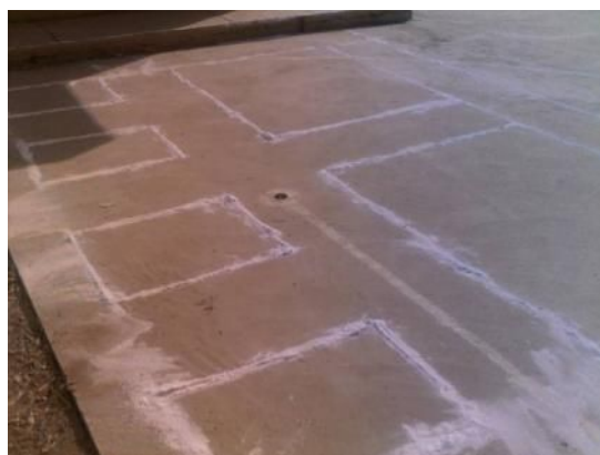
トイレ増築場所に白線を引いたところ (7月26日撮影)
