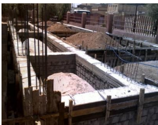
基礎部分のつなぎ梁打設作業 (8月17日撮影)
