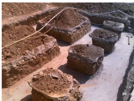
トイレ増築の基礎をコンクリートで固める 作業完了 (8月25日撮影)
