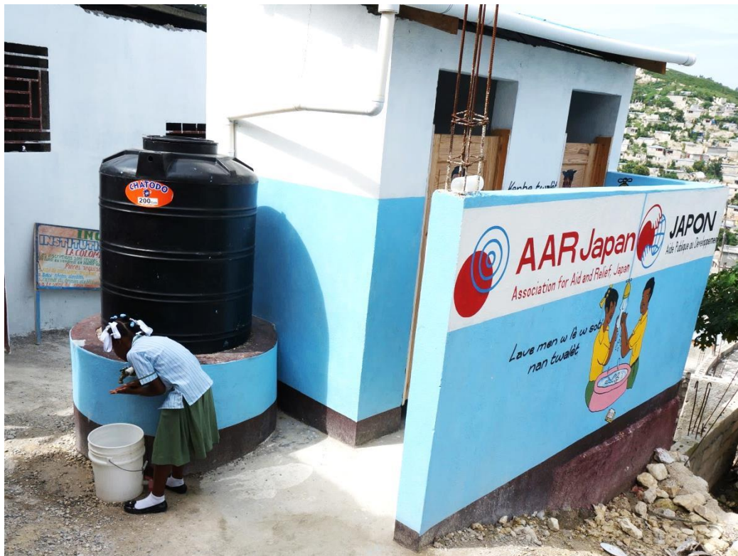
写真 2：完成したトイレと手洗い用簡易雨水貯水タンク。(2013 年 10 月 16 日 コロンブ校にて)
