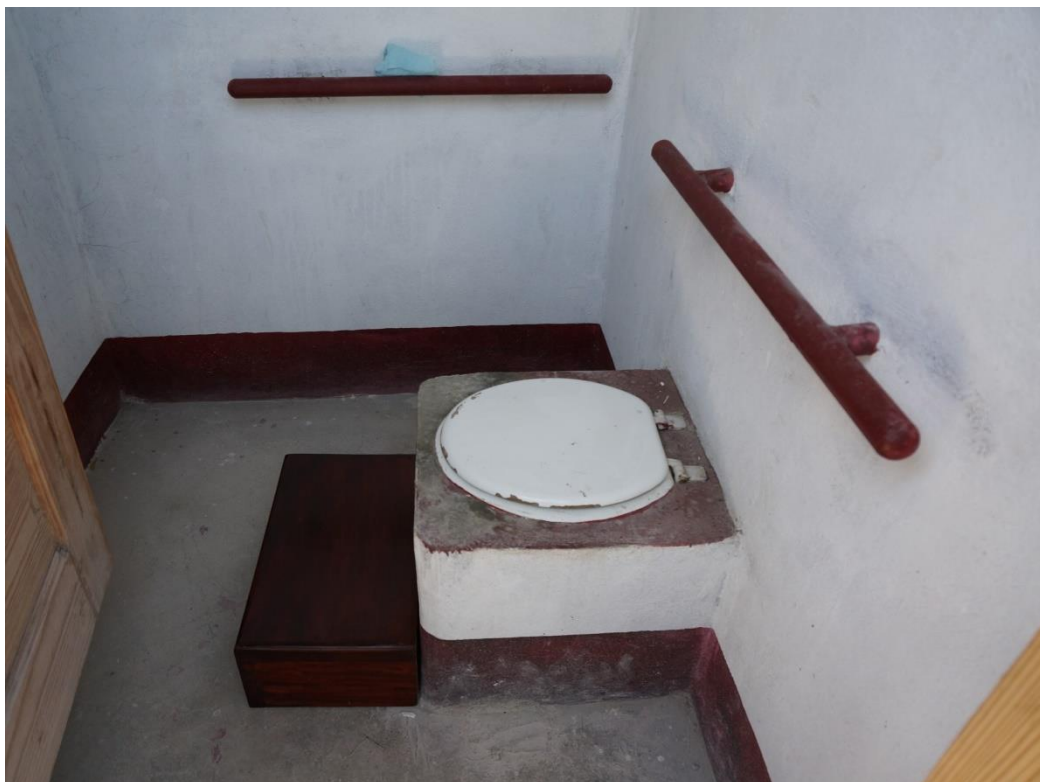
写真 4：完成したトイレ内部。障がい児への配慮の一つとして、手すりを設置した。また、低学年の子どもも利用しやすいよう、可動式の台を便器の前に設置した。（2014 年 3 月 11 日 コロンブ校にて）
