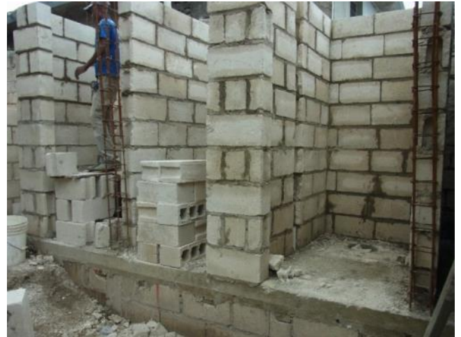
トイレのピットと土台、個室部分の建設を終了した。(2013年6月20日撮影)
