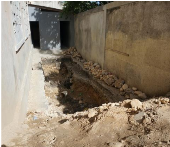
教師用トイレのピット、土台、個室部分の建設が完了した。現在生徒用トイレのピットの掘削を行っている。(2013年7月17日撮影)
