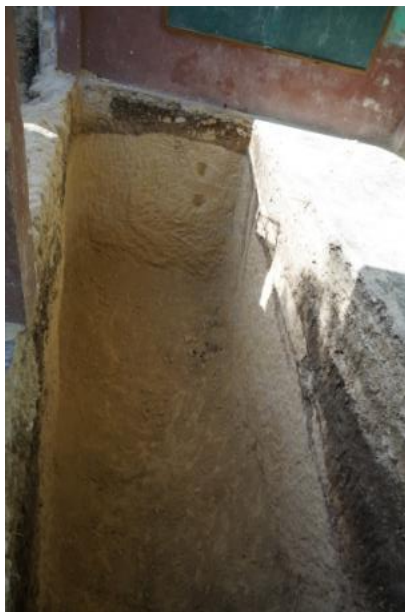
現在トイレのピット部分の掘削を行っている。(2013年7月17日撮影)
