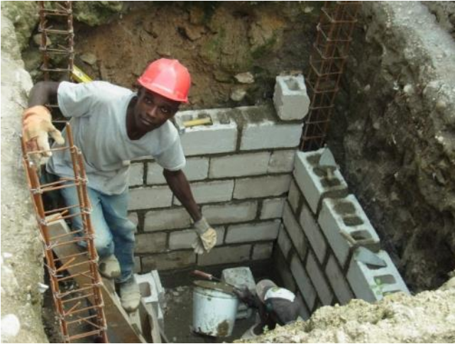
トイレピット掘削後に、ピット壁面をブロックと鉄筋で補強した。(2013年5月17日撮影)
