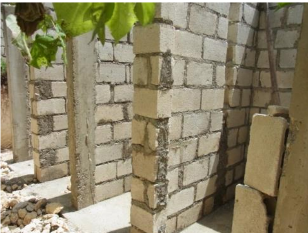
トイレのピット、土台、個室部分の建設が終了した。(2013年7月2日撮影)
