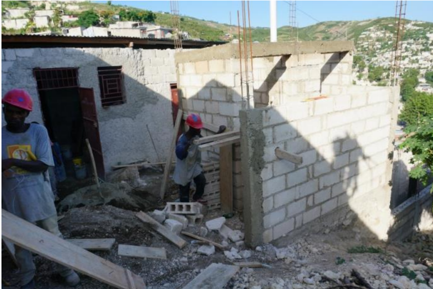
トイレのピットと土台の建設が終了し、個室部分の建設を行った。(2013年7月17日撮影)
