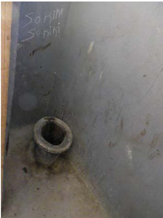
トイレの様子。全部で9基（小使用2基含む）ある。
