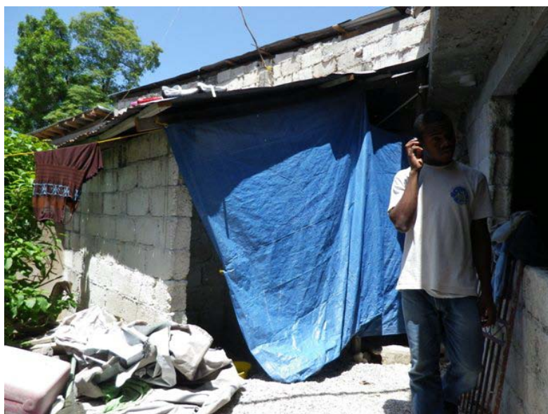
トイレの外観。
