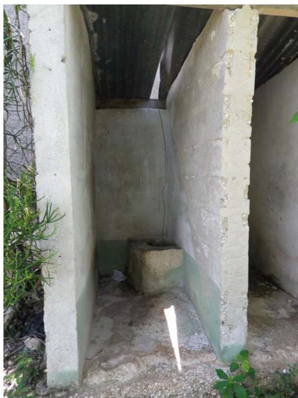
ドアのない既存のトイレ。
