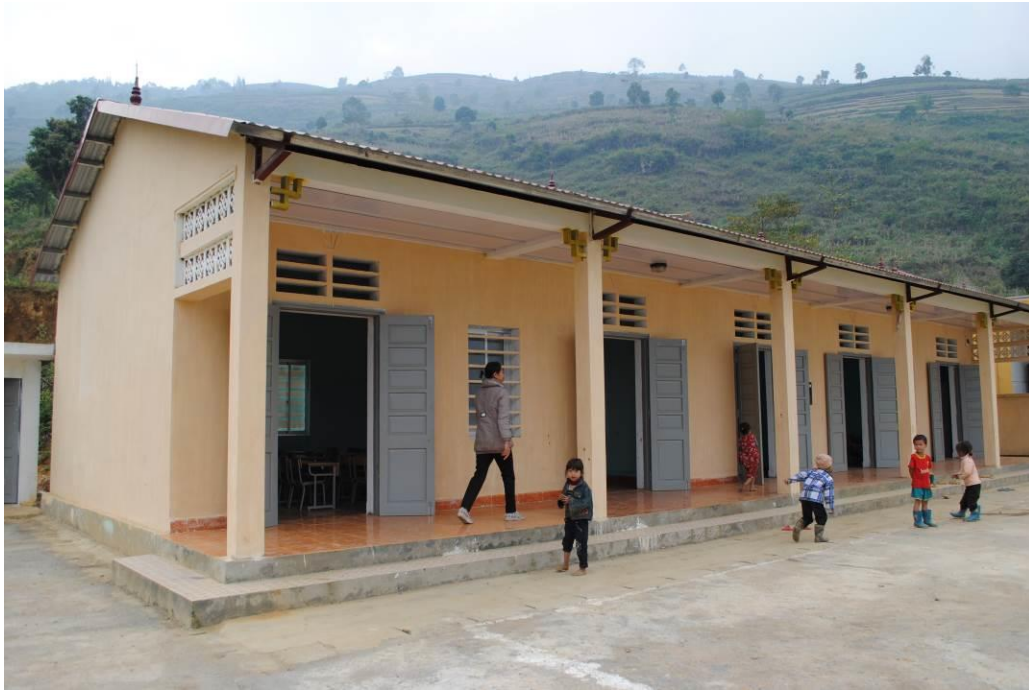
2教室と教員室を建設したルンバイ小学校(ハザン省シンマン郡)。以前は、土造りの住民集会所を学校代わりに使っており、建物も脆弱な上に子どもたちの家から遠く離れていた。新しい教室は村の中心部に建設され、「悪天候でも子どもたちが安全に学校に通えるようになった」と1年生担任のハン先生は語る
