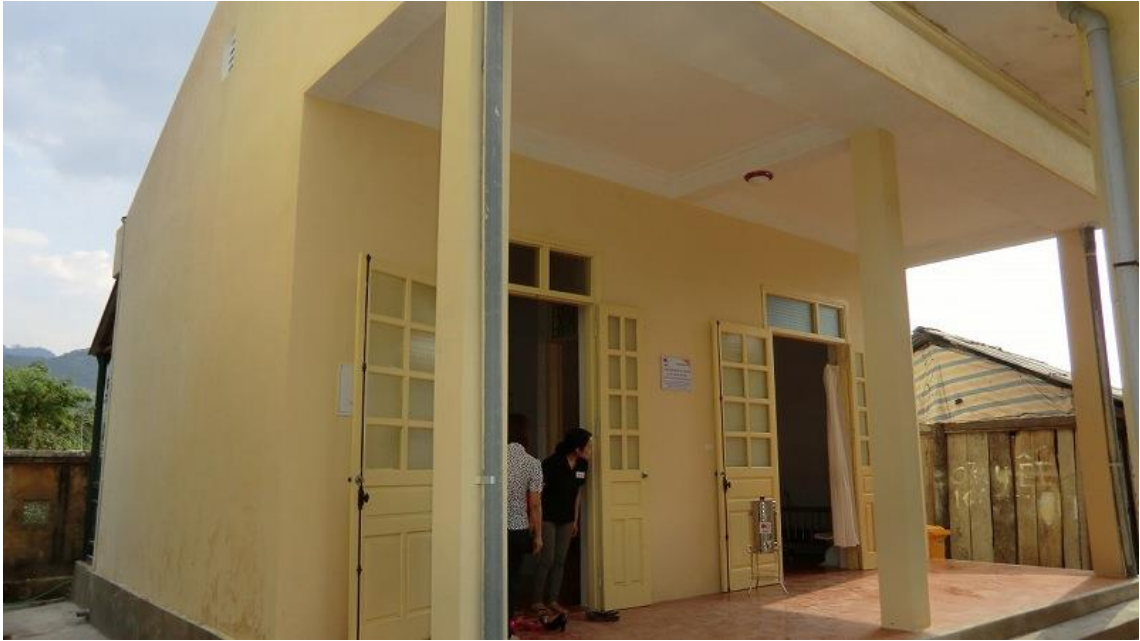
完成した Sa Long コミューン保健センターの産科室
