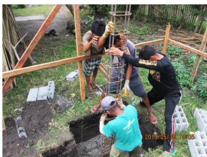
支柱の鉄筋の設置
