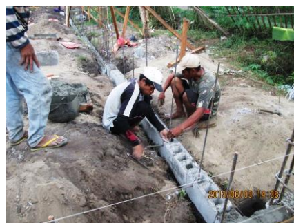
基礎部分へのコンクリート設置
