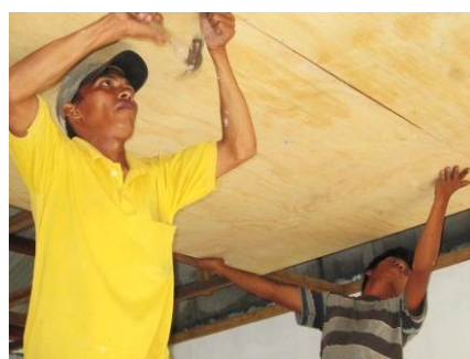
天井板の設置
