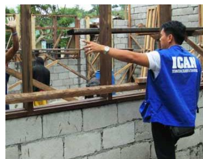
窓の枠組みの設置
