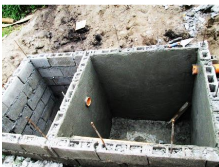
浄化槽の型枠
