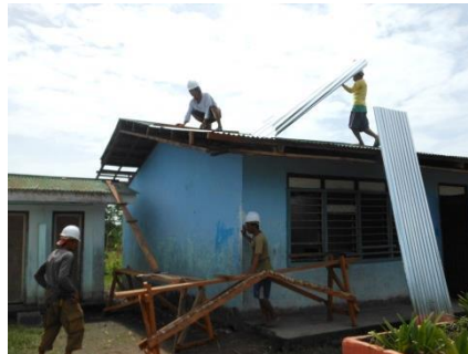
屋根のトタン板の交換
