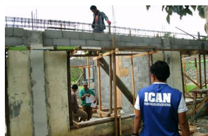
屋根の鉄骨を支える柱と梁
