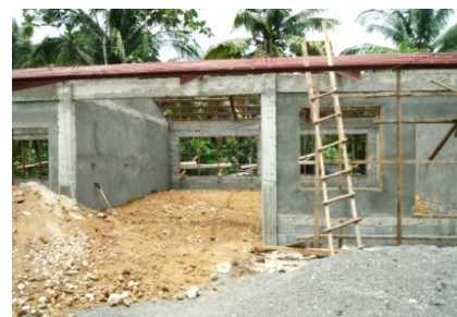
床の盛り土の搬入
