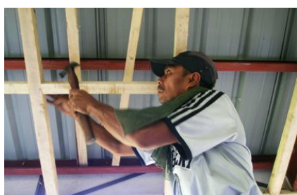
天井の設置工事
