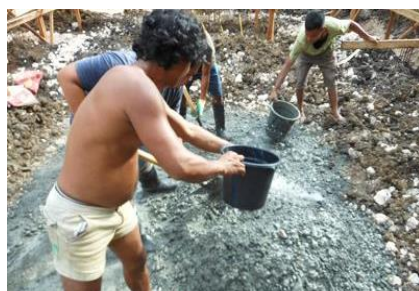
セメントと砂利を混ぜる
