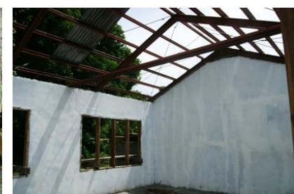
鉄骨の組み立てられた屋根
