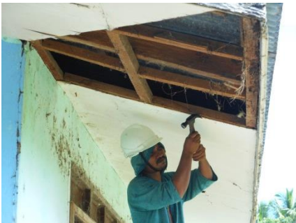
ひさし板の交換
