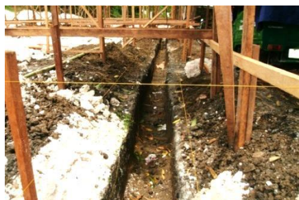
基礎工事が始まった現場
