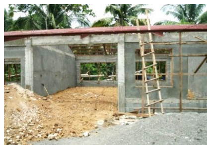
床の盛り土の搬入
