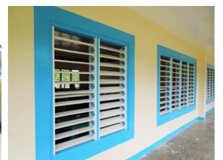
修復された窓枠
