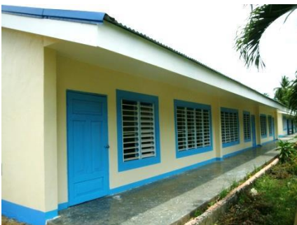
修復を終えた左の棟(3教室)
