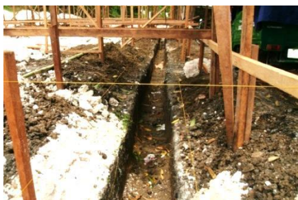
基礎工事が始まった現場
