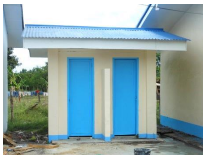
外装を修復したトイレ
