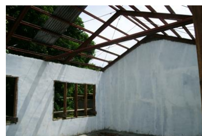
鉄骨の組み立てられた屋根
