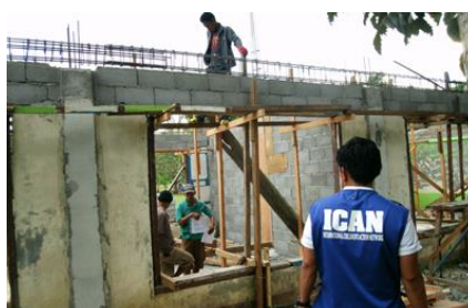
屋根の鉄骨を支える柱と梁
