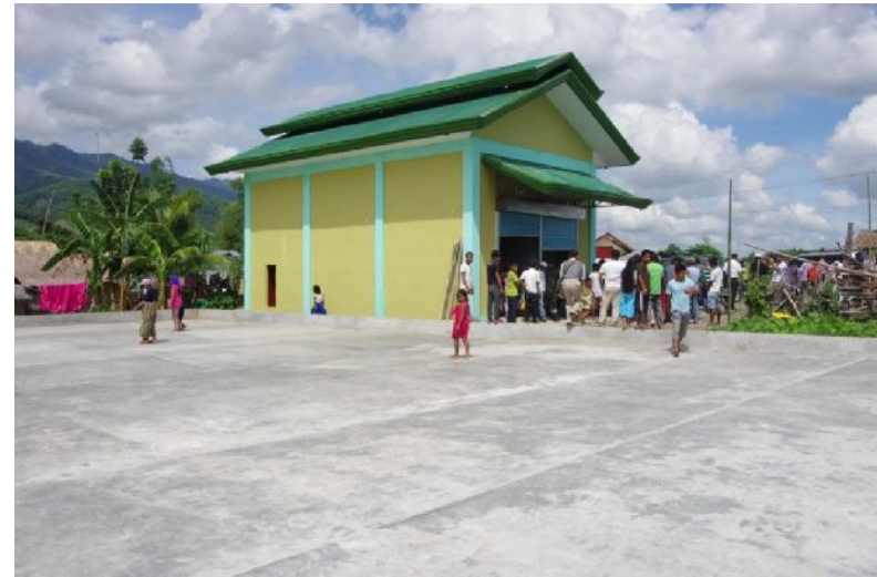
写真 2-2. 完成した倉庫と天日干し場。作物の収穫後に雨に濡らすことなく貯蔵することが可能となった。
