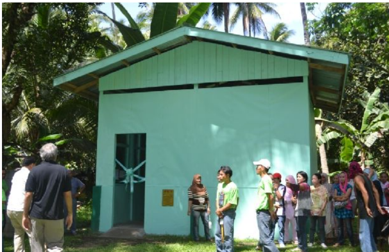
写真 1-1. 完成したキャッサバ用の収穫後処理施設。雨や風にさらされることなく、キャッサバを乾燥させることが可能となった。
