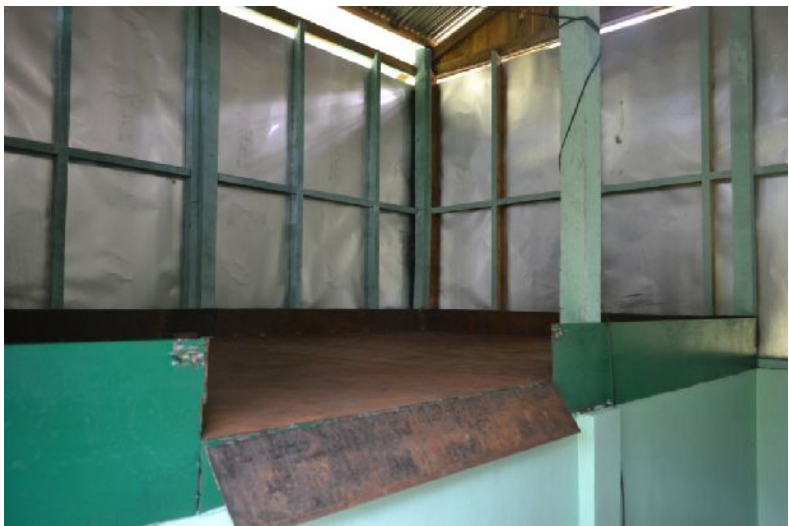
写真 1-3. 施設内部の様子。段の上に生のキャッサバを並べ、鉄板の下から熱風を送り乾燥させる。
