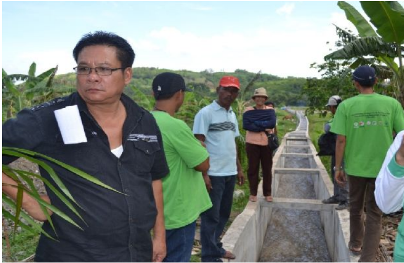
写真 2-1. 完成した用水路。未然に洪水の頻発を防ぎ農家の人々は 2 期作が可能となる。
