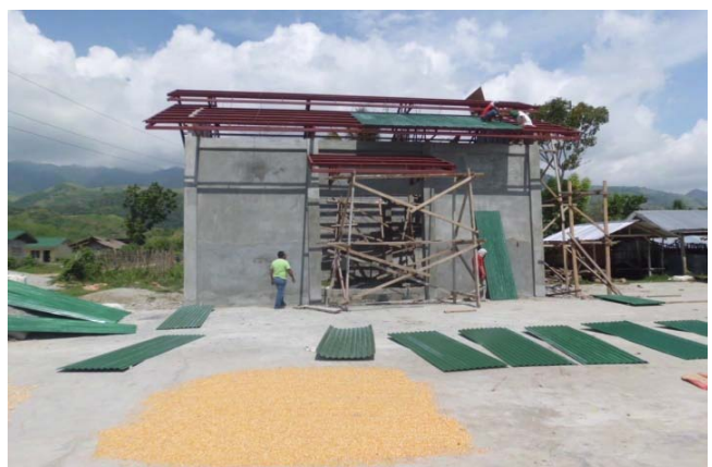
エスペランザ町で建設された倉庫と天日干し場
