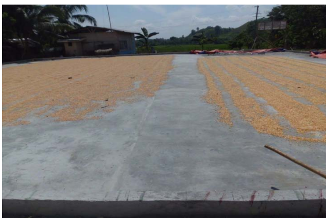
エスペランザ町で建設された天日干し場
