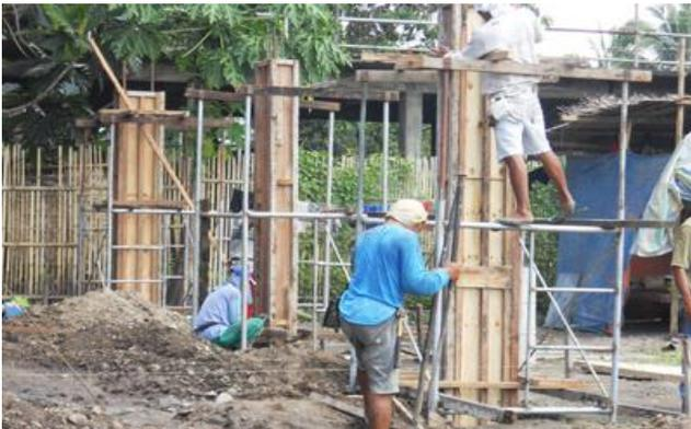
工事着工から 5 日目。深く掘られた穴に鉄骨の柱が埋め込まれた。コンクリートで柱を固め、頑丈な構造を作る。
