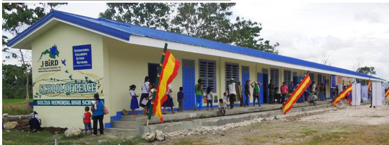
完成した1棟6教室の校舎（スルタン・メモリアル中学校）
