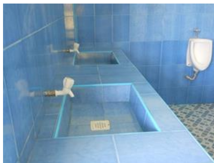
トイレ内の手洗い場
