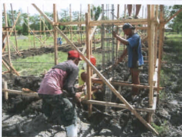
地面に深く掘られた穴に、鉄骨を埋め込んでいき、頑丈な柱を作る。
