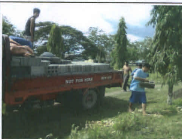
学校の壁になるブロックの運搬
