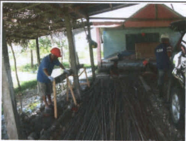
学校の土台となる鉄骨や材木が運び込まれ、必要なものが揃っているかひとつひとつ確認作業を行う。
