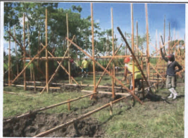
図面に沿って足場が組まれ、本格的な工事が開始
