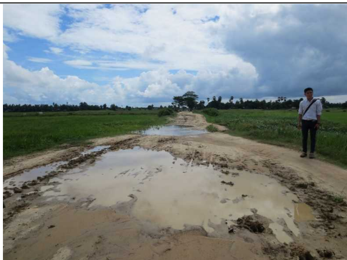
④ネピドー連邦直轄領 レイウエイ T/S カンラー村⇄タロップン村間 周辺 64 村の村民が利用し農家達が農作物を市場へ出荷する為のメインの道でありながら、毎雨期後にダメージを受け、村民らで補修を試みるも効果が持続せず、作物の運搬が困難となっている。
