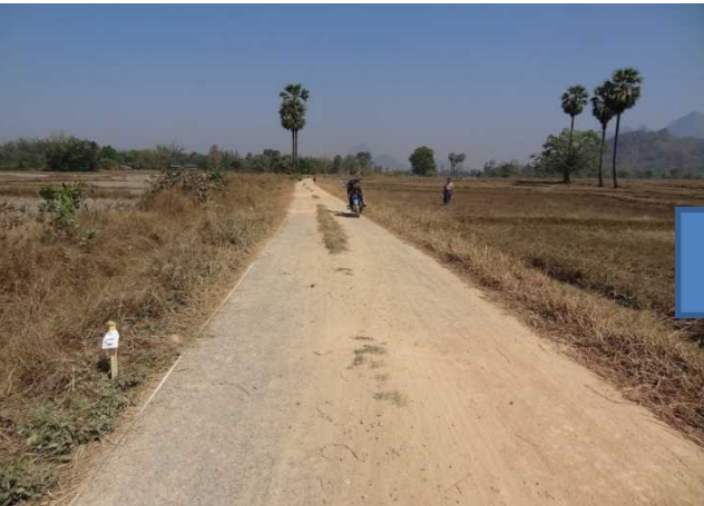
施工前：雨期時には道路が冠水し車両、人の通行が困難であった。(水位 30cm~80cm)
