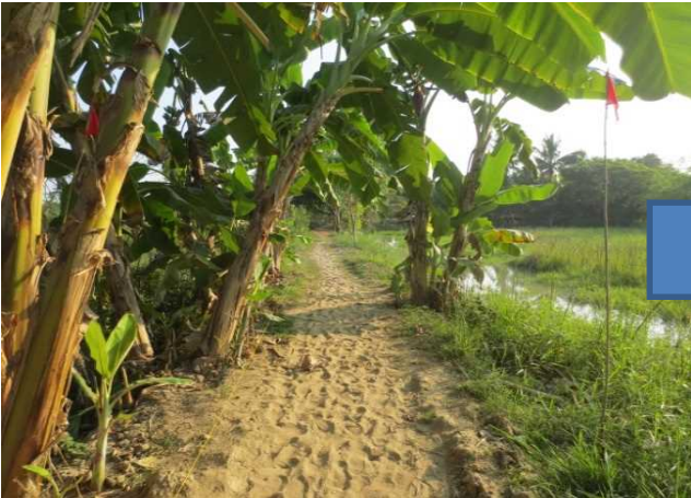
施工前：雨期時は道路全体がぬかるみバイク、自転車、通行不可。
