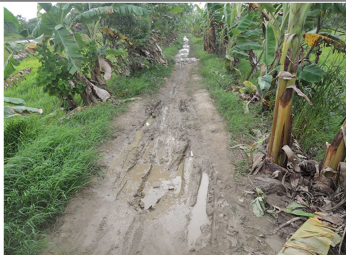
①エーヤワディー地域 ピャボン T/S チョンチャイ村 施工前：近隣村民約 17,000 人がこの道路を利用しており、住民にとって大変重要な道路であるが粘性土と碎石のみで作られた同道は雨季になると通行が困難となり、長年村民を苦しめている。
