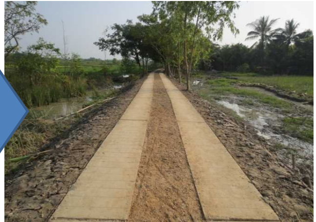
施工後：雨期時でもバイク、自転車、人の通行が容易となり、市場、学校、病院へのアクセスが確保された。
