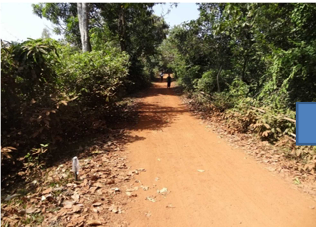
施工前：雨期時には道路が冠水し車両、人の通行が不可であった。(水位 1m)
