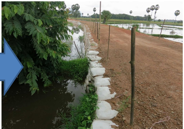
施工後：雨期時でも市場、学校、病院へのアクセスが確保された。
