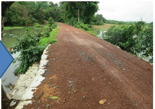
施工後：村民らと土のうを使用した嵩上げ工事を行い、雨期時でも市場、学校、病院へのアクセスが確保された。
