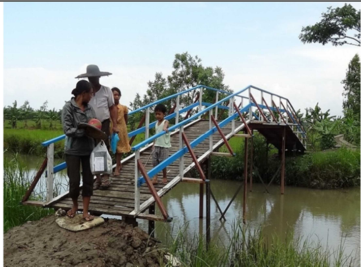
②エーヤワディー地域 ピャボン T/S カンター村 施工前：村民達で建設した橋梁は調査の結果、強度が十分でなく危険な状態である事が判明。また、橋の高さが十分でない為、雨期に川の水位が上昇した際、橋の下を船が通行不可となり不便を強いられている。
