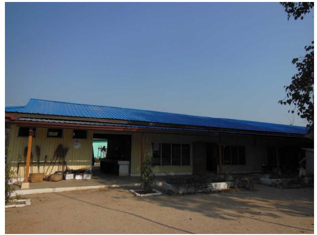
【屋根の張り替え②】新しく青色塗装のトタン屋根に張り替えたことで雨漏りが無くなった。
