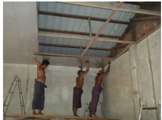
【男性職員寮の増築①】従来は倉庫として利用していた部屋に天井を設置している様子。
