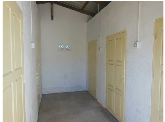
【男性職員用トイレ・水浴び場】左側に水浴び場、右側にトイレ3箇所を新しく設置した。
