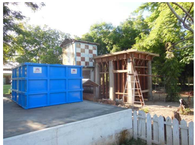
【飲料水タンク新設工事】2014 年 8 月現在、手前の脚部分まで、工程表に沿って工事を進めている。
