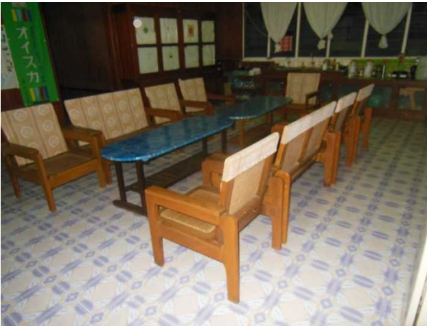
【応接間の床】改修により床下に脚が突き抜けそうになること無く、歩くときも心配が無くなった。
