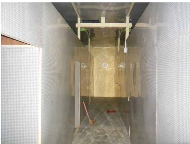
【男性職員寮の増築】従来の倉庫内を改装して 8 部屋の個室を設置した。
