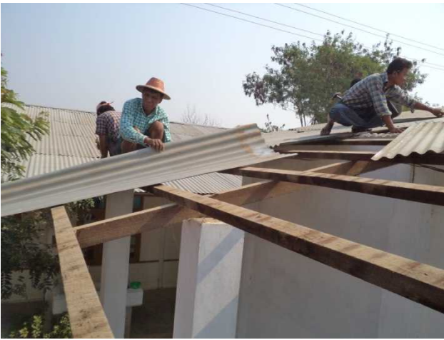
【屋根の張り替え①】老朽化で雨漏りのする古いトタンを外している様子。
