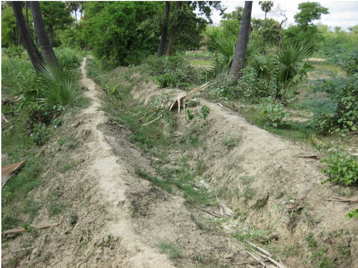
修繕前の農業灌漑水路の写真
