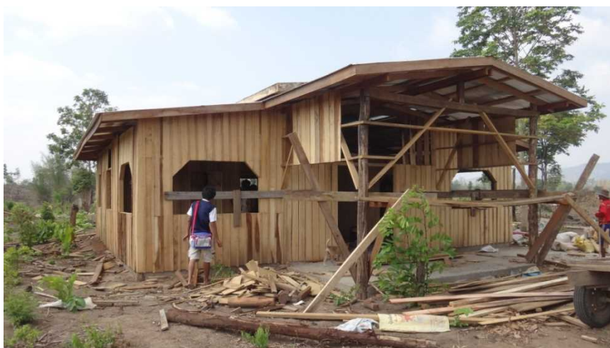
上 先行して建設中の農業作業所
