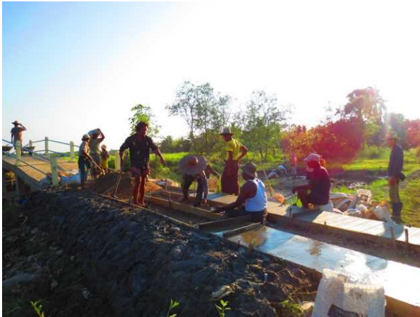
9. 現在では住民のみでコンクリート施工含め 道路補修工事が可能になった
