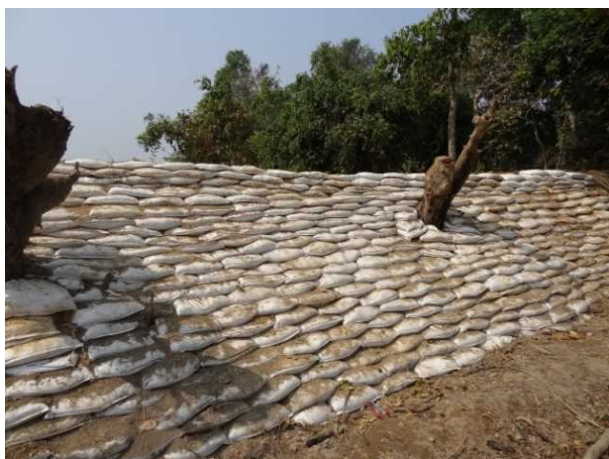
19. 土のうによって嵩上げされた道路の側面
