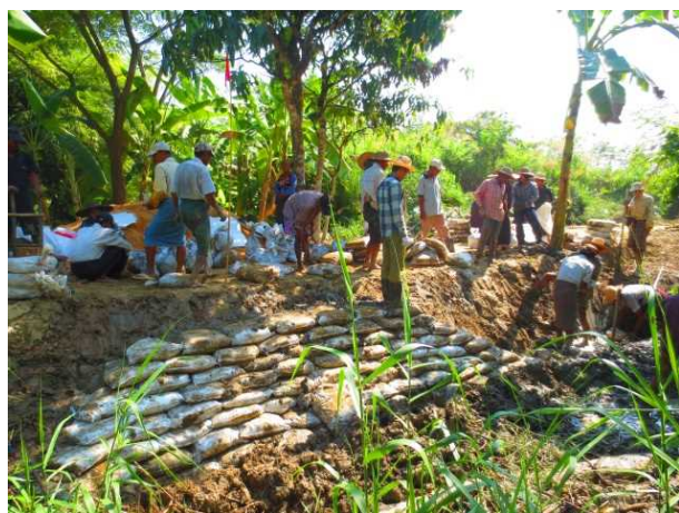
4. 住民研修 土のうに中詰めする土は粘土を利用
