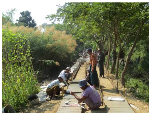
6. 施工現場 コンクリート施工
