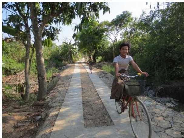
14. 施工後 道路補修後自転車通行が可能となった。
