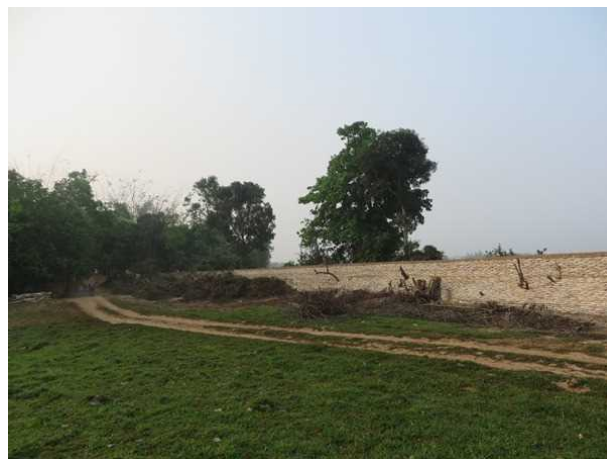
20. 土のうによって嵩上げされた道路
