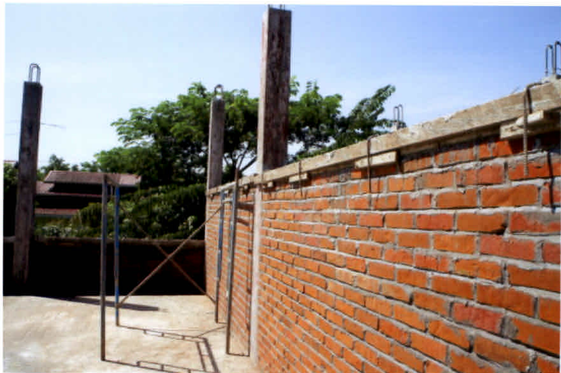
2階間仕切り壁と支柱
