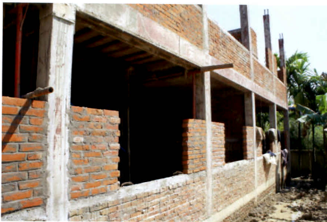
建築現場全景
