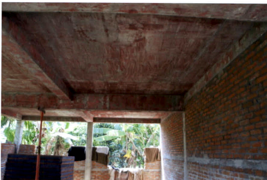
1 階間仕切り壁と 2 階スラブ
