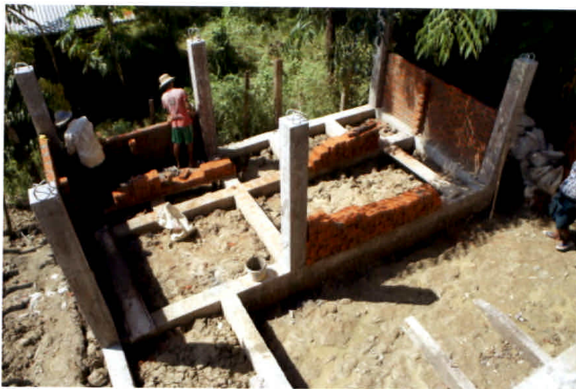
トイレ工事開始
