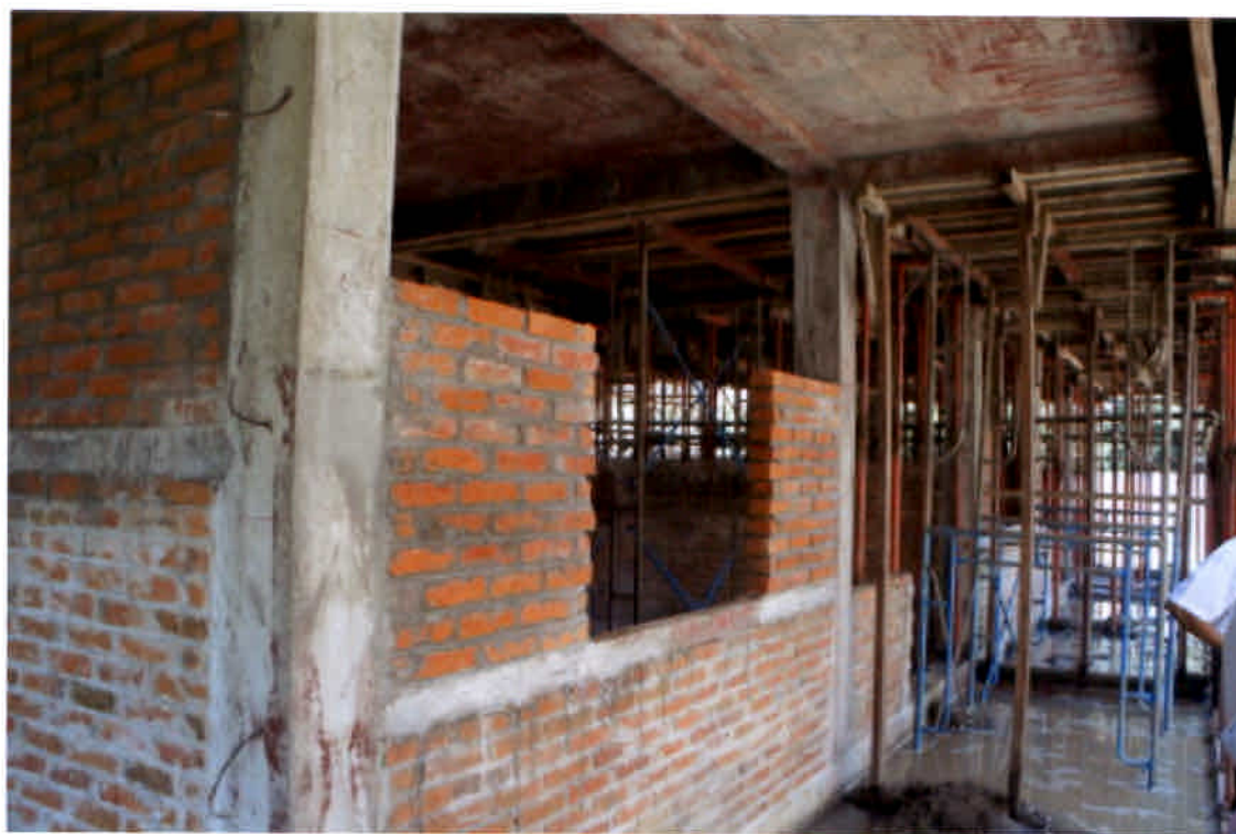
1階廊下側窓枠工事
