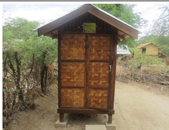
(活動 3-6) 建設されたモデルトイレ (Htan Chauk Pin 村)
