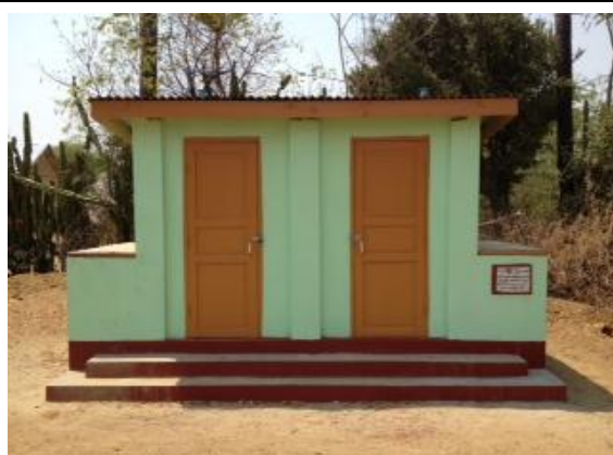
(活動 3-6) 建設された学校トイレ (Nyaung Hla 村)
