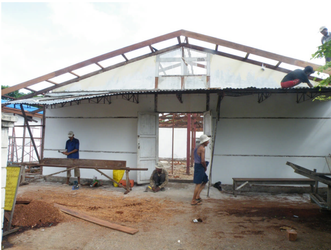
老朽化が激しかった職業訓練校女子寮の改築の様子。梁を入れ替えた。（撮影：平成 24 年 6 月 5 日、ヤンゴン地区）
