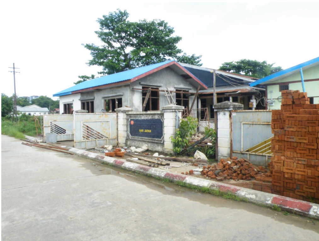
建設中のコンピュータークラス（左手前の建物）。完成後には、受け入れ訓練生数が6名増え、計12名の訓練生が受講できるようになる。（撮影：平成24年6月5日、ヤンゴン地区）
