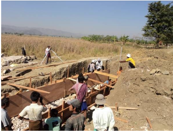
余水吐工事の様子（2012年1月18日）
