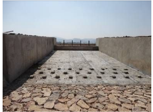
整備したスピルウェイ（余水吐け）
