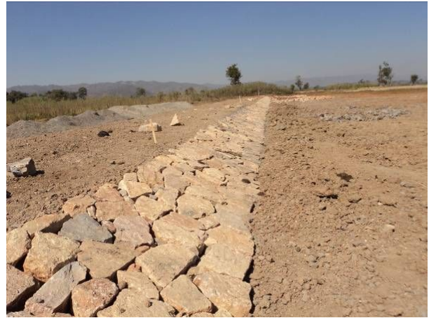
堤石積みの様子(2012年1月23日)
