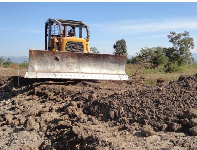
(左)ドーザーで堤防の盛土をならしている様子、(右)古い放水口（大雨のために側面が破損している）
