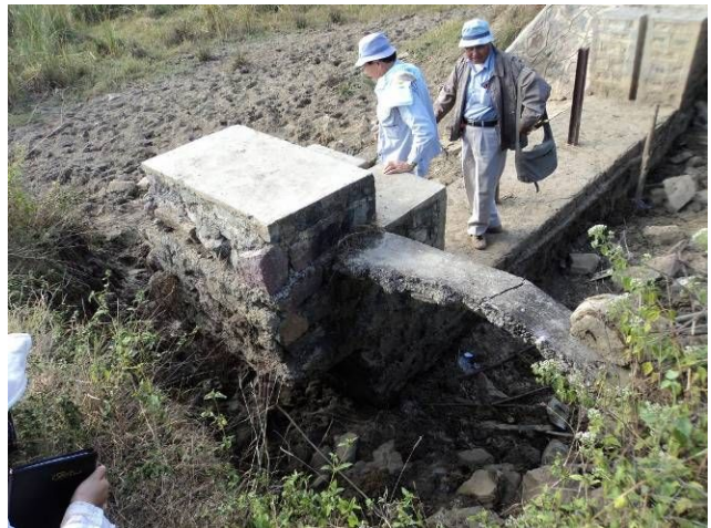
(左)ドーザーで堤防の盛土をならしている様子、(右)古い放水口（大雨のために側面が破損している）
