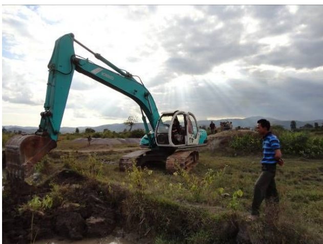
(左)測量をしている様子、(右)バックホーでダムの盛土を掘り出す作業をしている様子
