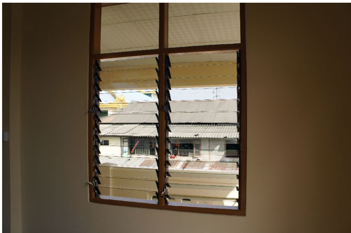
廊下側硝子ルーバー窓
