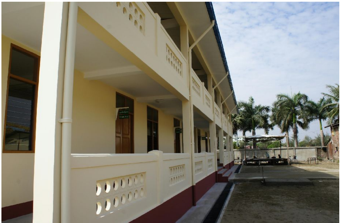
校舎周り排水溝
