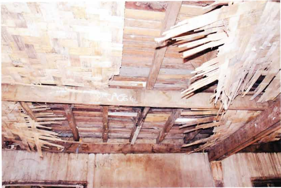
既存校舎の1階教室(中央)天井
