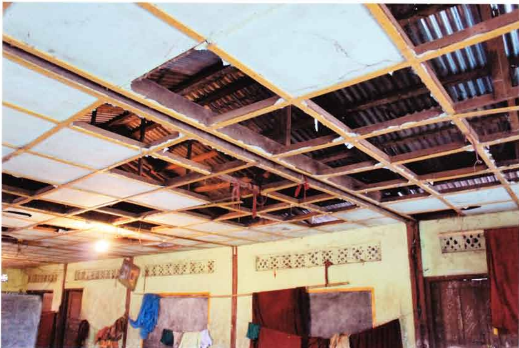
既存校舎の2階教室の天井
