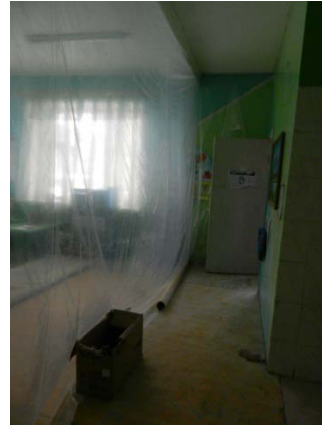
工事中改修工事現場から出る埃を巻き散らさないための ビニールシート。（子どもの健康に配慮して設置） 第91番幼稚園にて：2012年11月23日
