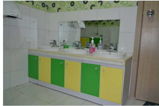
ソングノ・ハイルハン地区第91番幼稚園 (改修後) 2012年12月 子どもが使いやすい工夫がされている手洗い場
