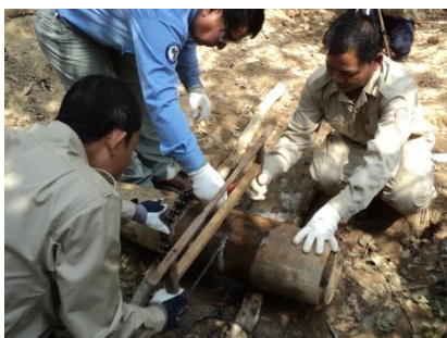
④電気のこぎりが届かない部分を 手動で切断
