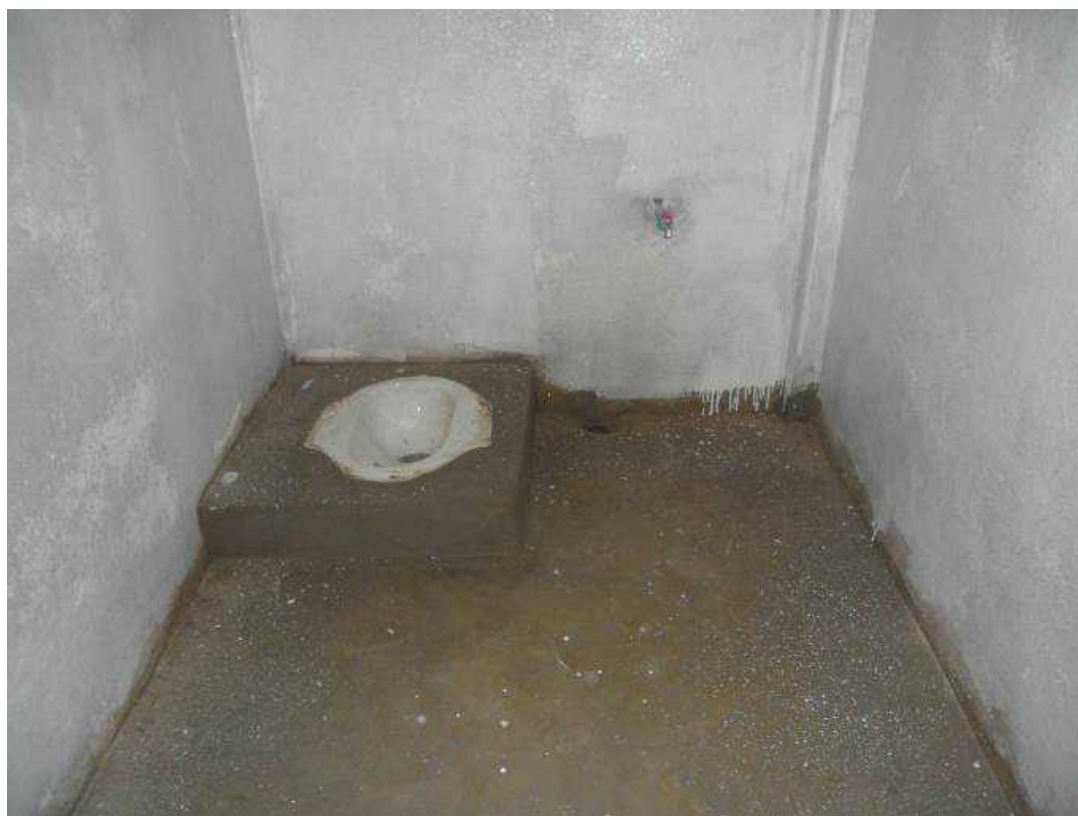
写真 8：トイレ内部（ドンケオ小学校）
