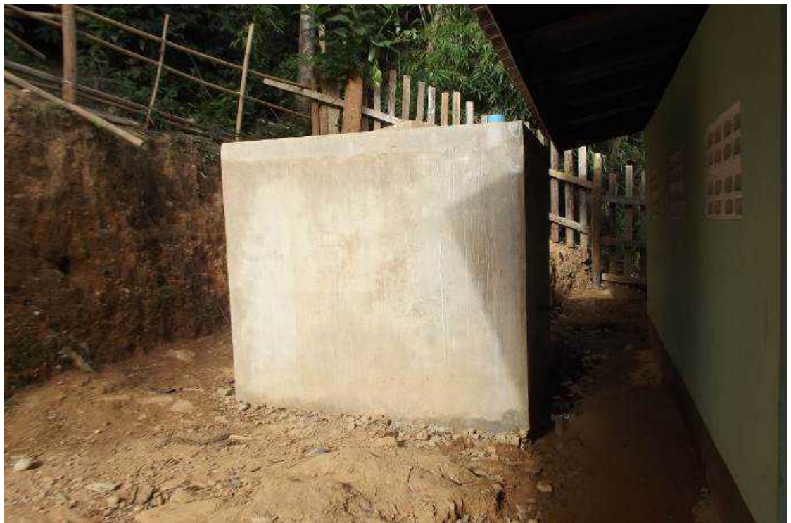
写真 28 : 給水タンク (プーカン小学校)
