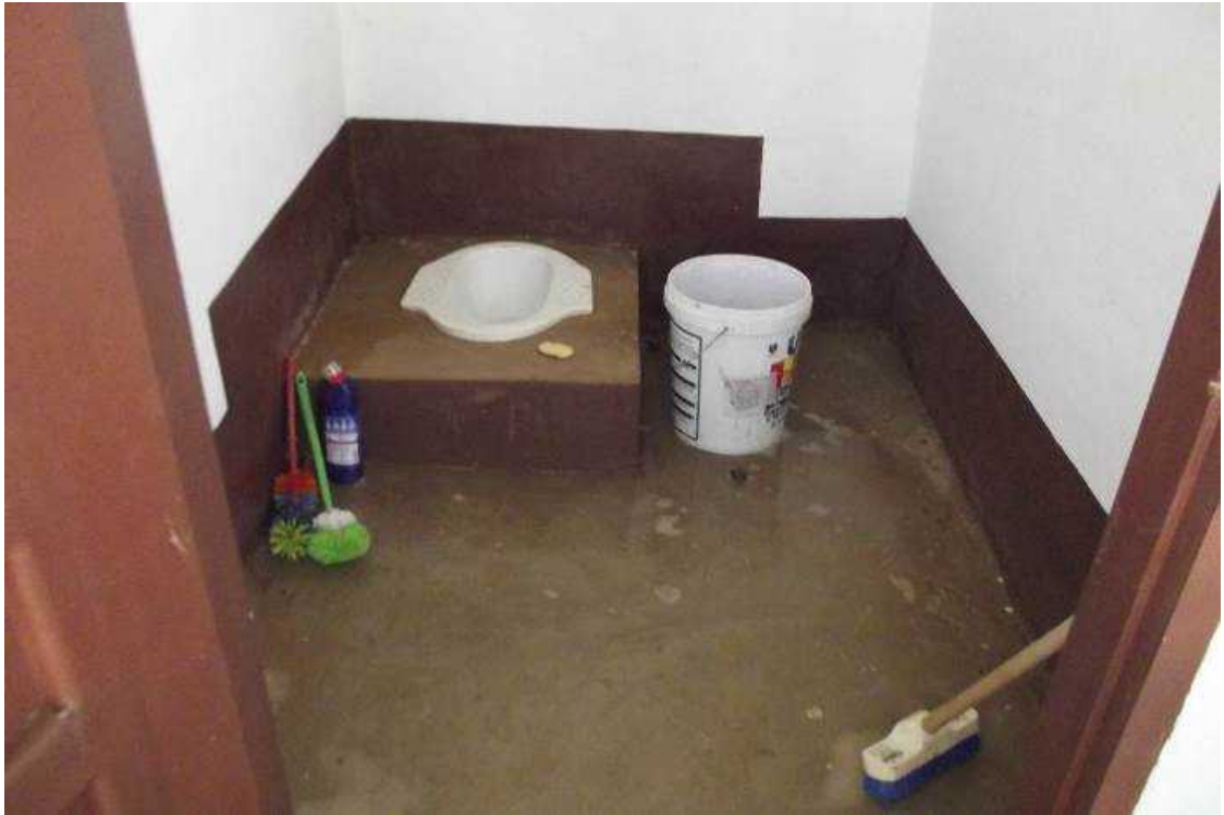
写真 27 : トイレ内部 (プーカン小学校)
