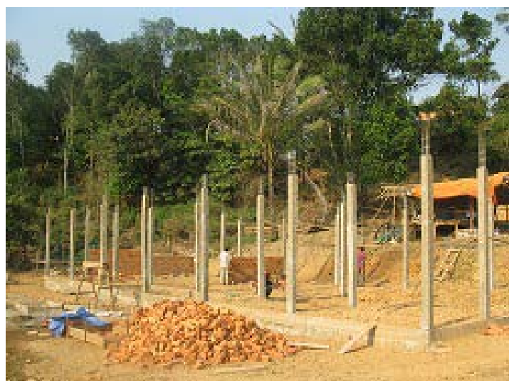
建設工事の開始後まもなくの様子。2013年3月
