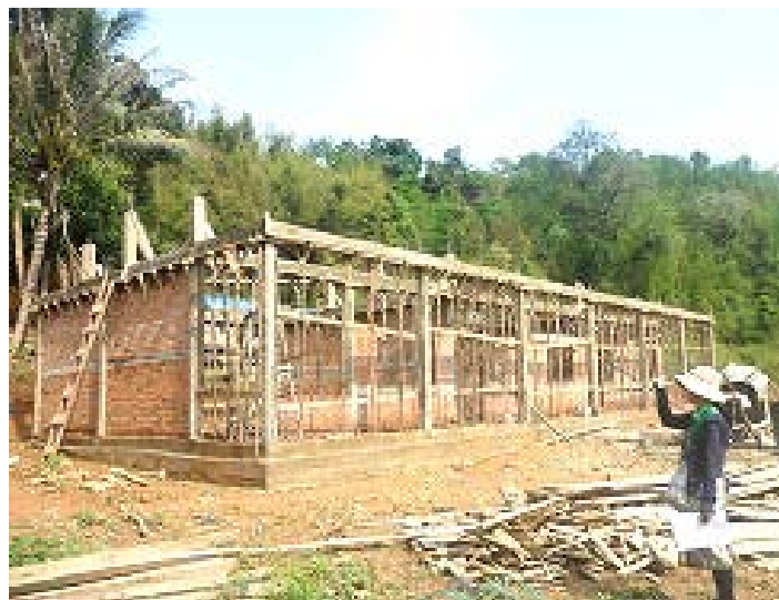
建設工事進捗の様子。2013年4月
