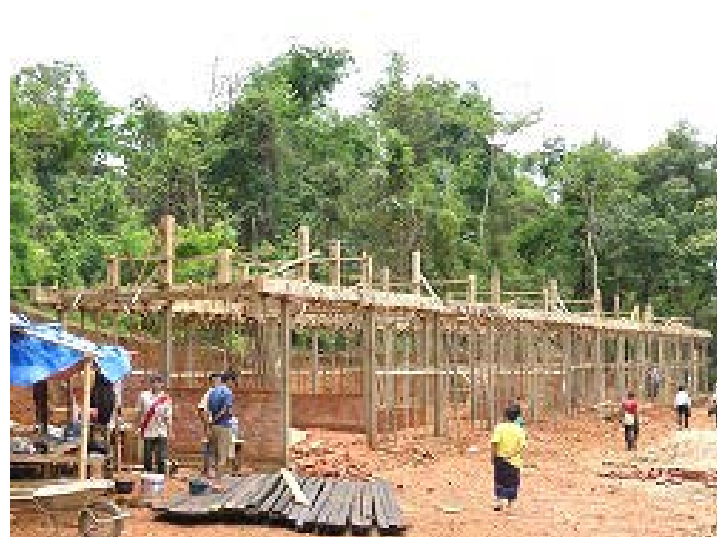
2013年4月時点の様子。 小学校校舎が完成すれば、多くの児童が、雨風や強い日差しにさらされず、安全で学習に適した環境が整えられる。
