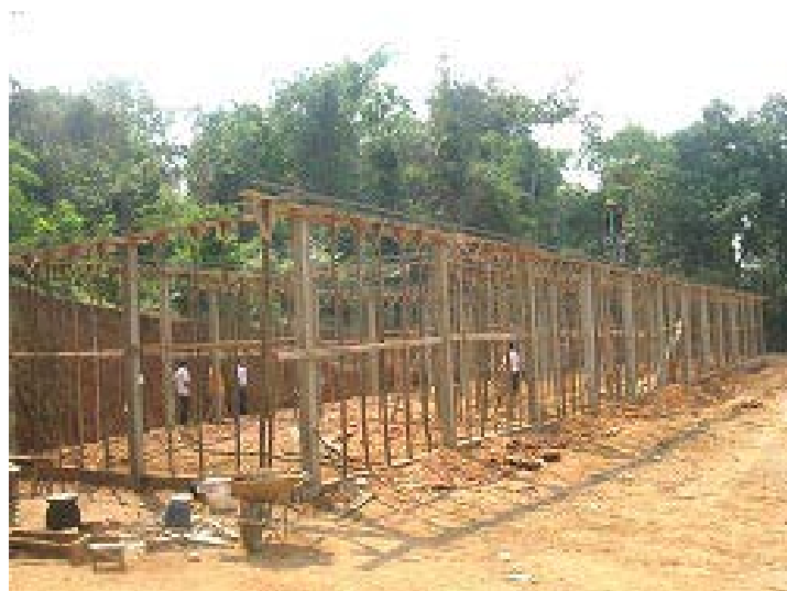
契約が結ばれた直後に開始された工事の様子。 2013年3月。
