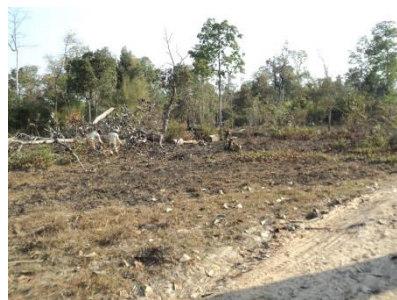
大量の爆弾破片が地中に残っていた為、探査に日数を要した不発弾処理現場
