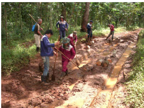
雨季における処理現場への進入路の整備
