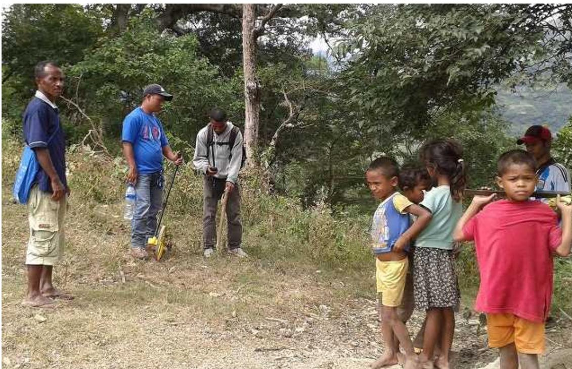
カイラコ準県ライヘウ村における水供給システムの距離測定の様子（写真は蛇口の位置をGPSで測っている所）そこから得られた情報を用いて設計が行われる。
