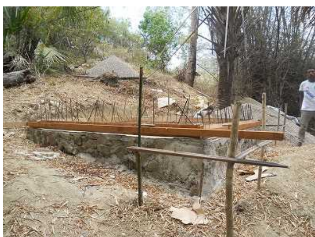
貯水槽本体の鉄筋を設置する様子
