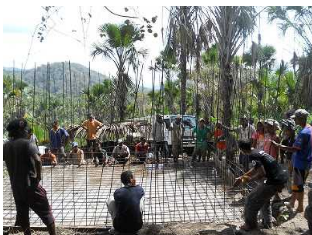
貯水槽本体の鉄筋を設置する様子
