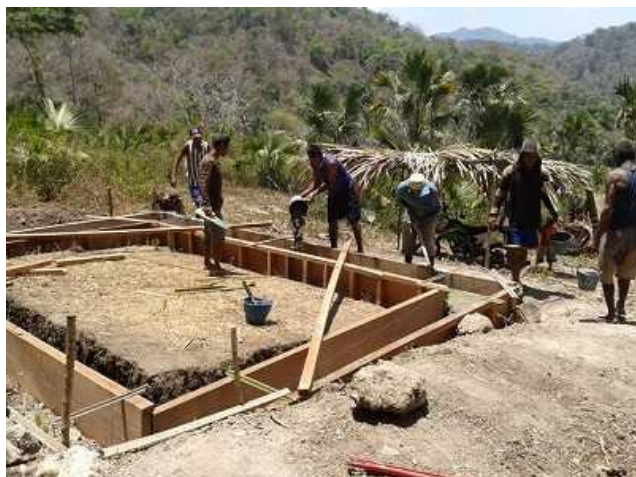
貯水槽の基礎工事の様子
