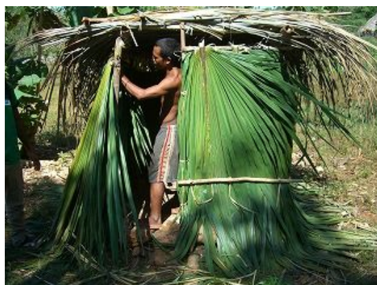
トイレの壁を作る受益者の様子
