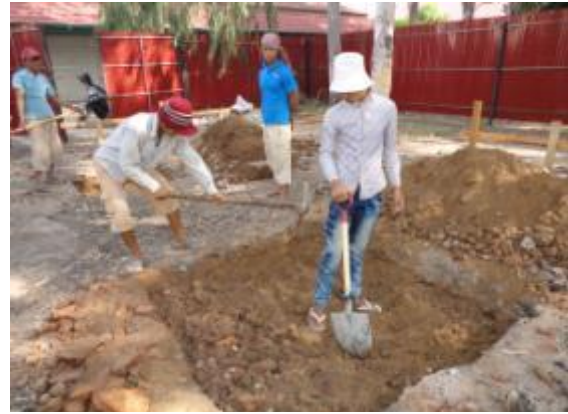
柱の基礎工事のために地面に穴を掘る作業員(2012.12.21)
