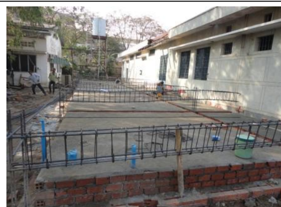
建物の土台の基礎工事。コンクリートの上に鉄で組んだ板を敷き、更にコンクリートを流し込む。(2013.1.20)
