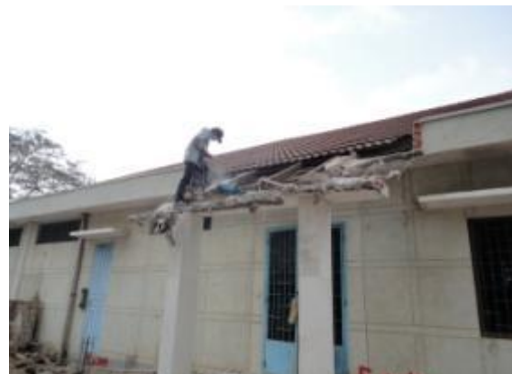
手術棟の東側(拡張する部分)の屋根、外付けの階段、柱などの取り壊しを行った(2013.1.15)
