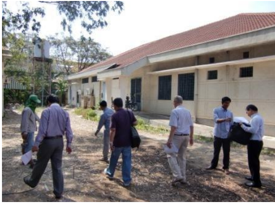
基礎工事開始時に、関係者が、汚水タンクや電気線の場所について確認した。(2012.12.17)
