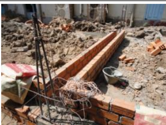
地中梁の底板(フーチン)が、地面に埋め込まれた。(2013.1.16)
