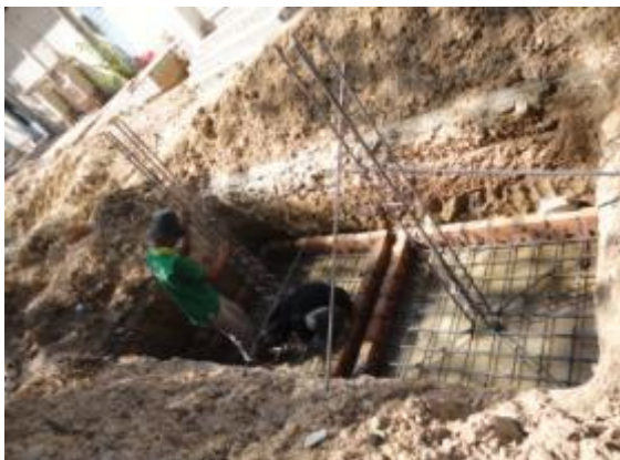
柱の基礎工事。地中梁の底板(フーチン)を穴に沈めた。(2013.1.4)
