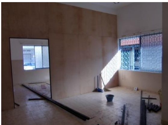
工事期間中、手術室として使用するために、外科病棟一階にある患者部屋の真ん中を仕切り、二部屋に分けた。(2011.12.12)
