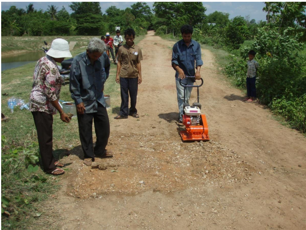
道路維持管理セミナーでの道路維持管理委員による道路損傷箇所補修実習
