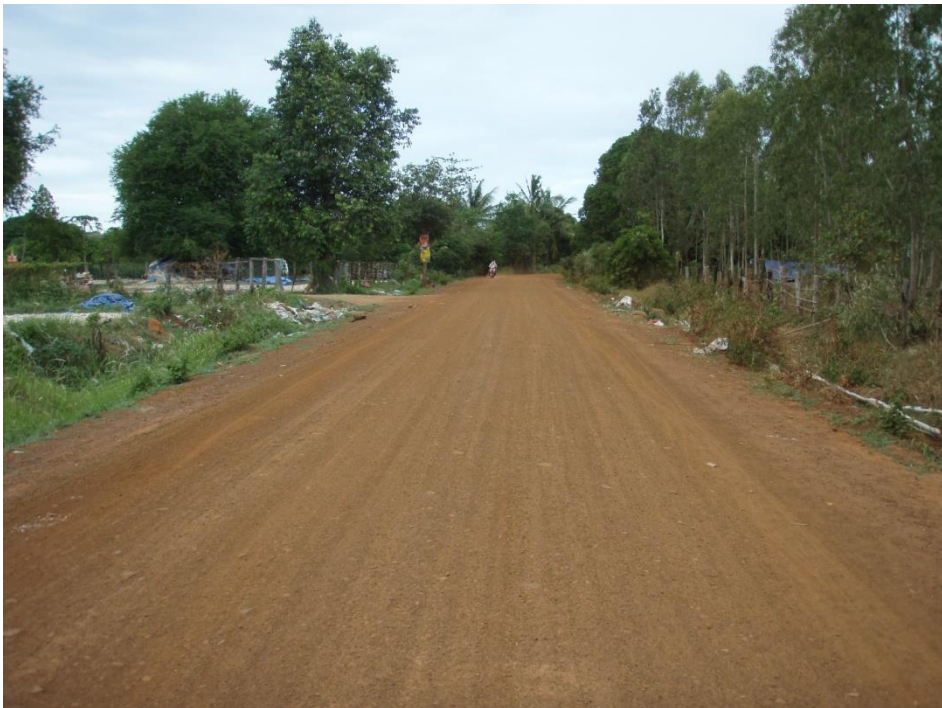
PDRDによる補修後の農道に接続する道路（２０１２年６月）
