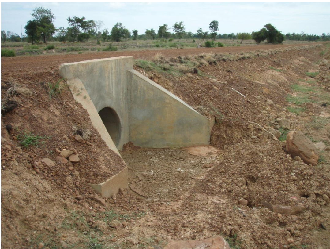
パイプカルバート
