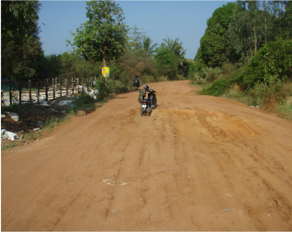
補修前の農道に接続する道路（２０１２年３月）
