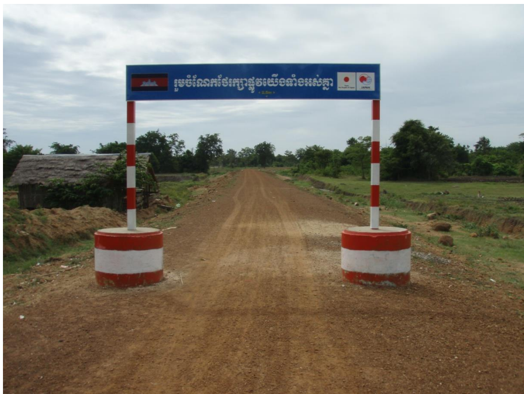
農道入口ゲート（大型車両進入防止バリアー）
