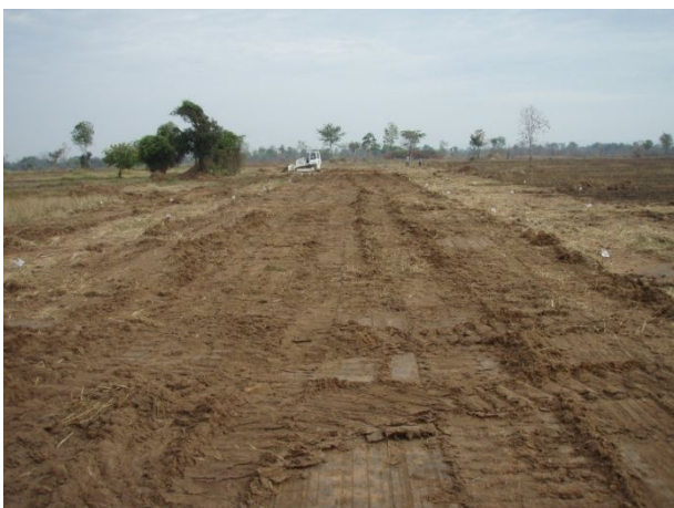
5. ブルドーザーで整地
