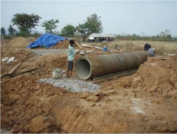
7. カルバート工事
