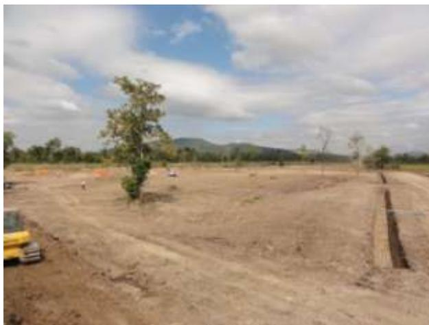
右: インフラ専門家指導の下、CMACのインフラチームによる整地、右端の側溝の右は、新設の道路
